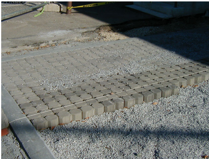
Figura 150 - Exemplo de piso poroso para permitir a captura e infiltração de água de chuva.
