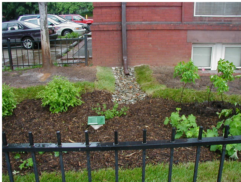
Figura 152 - Desconexão do coletor de água pluvial de canaletas de escoamento rápido, e encaminhamento a área permeável.
