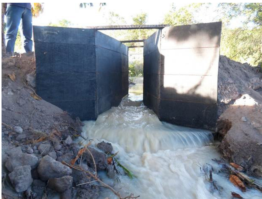
Figura 15.3 - Exemplo de Calha Parshal, construída em madeira, para estimativa de disponibilidade hídrica para dimensionamento de pequeno barramento para fins de irrigação, em Alagoas.
