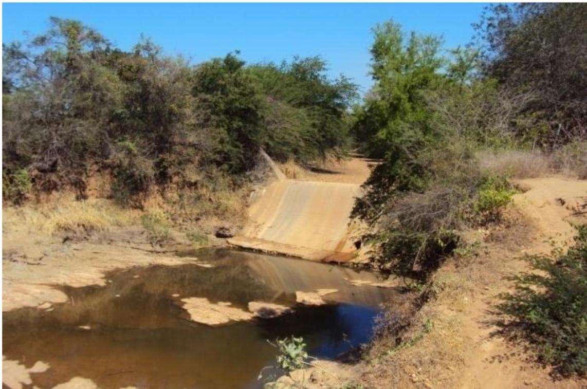
Figura 5.33 - Riacho Buriti do Meio que se encontra seco e assoreado a montante do barramento. Fonte: EcoPLAN-Lume-Skill, 2011.
