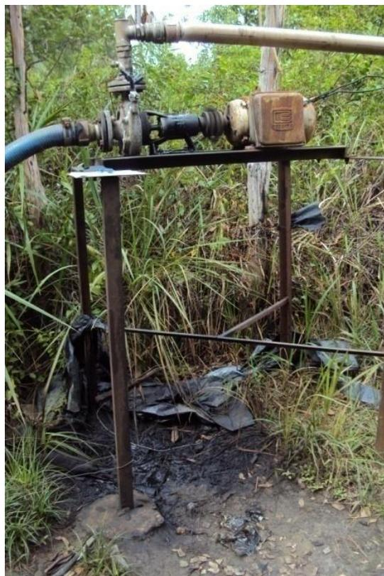
Figura 5.40 - Vazamento da bomba de captação que se encontra próxima ao ribeirão. Fonte: Ecoplan-Lume-Skill, 2011.
