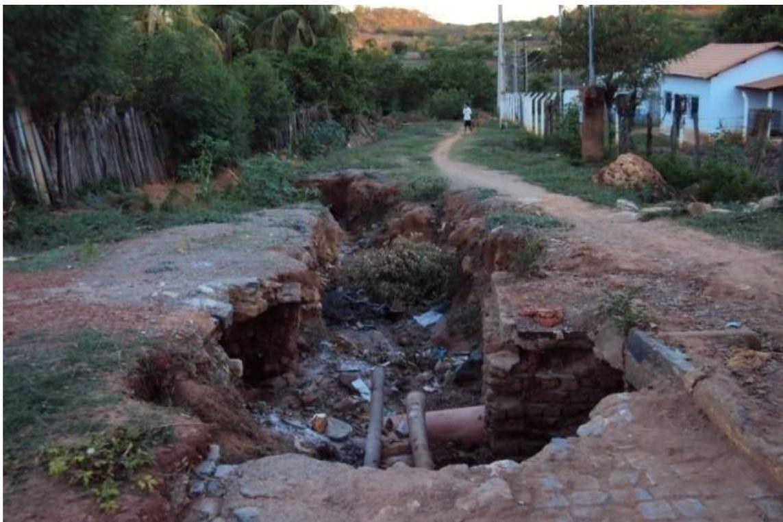
Figura 5.100 - Erosão formada na rua Alagoas no distrito de São Sebastião dos Poções, onde o material carrega para o riacho dos Poções. Fonte: Ecoplan-Lume-Skill, 2011.
