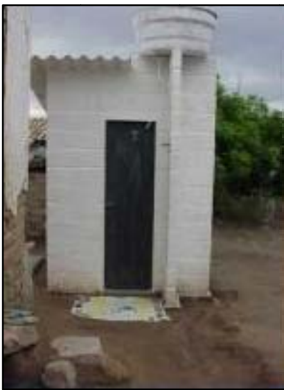
Construção de Módulos Sanitários
