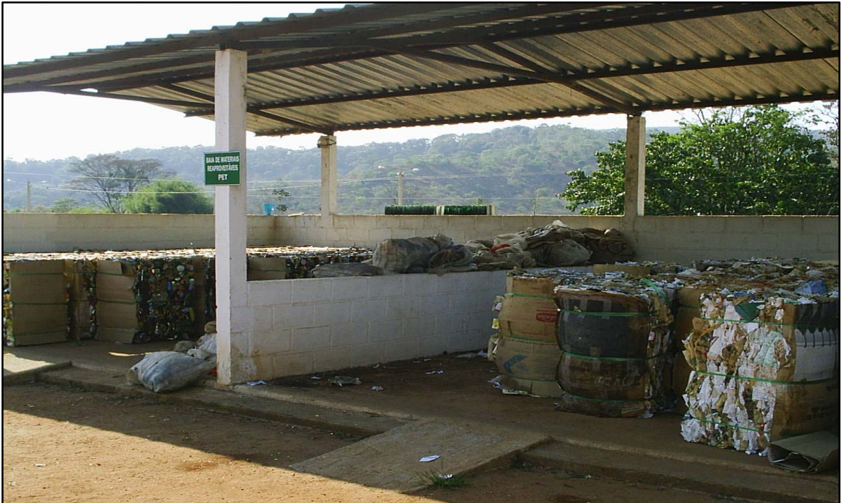
Figura 8.10 - UTC - Unidade de triagem e compostagem - Processamento de recicláveis.
