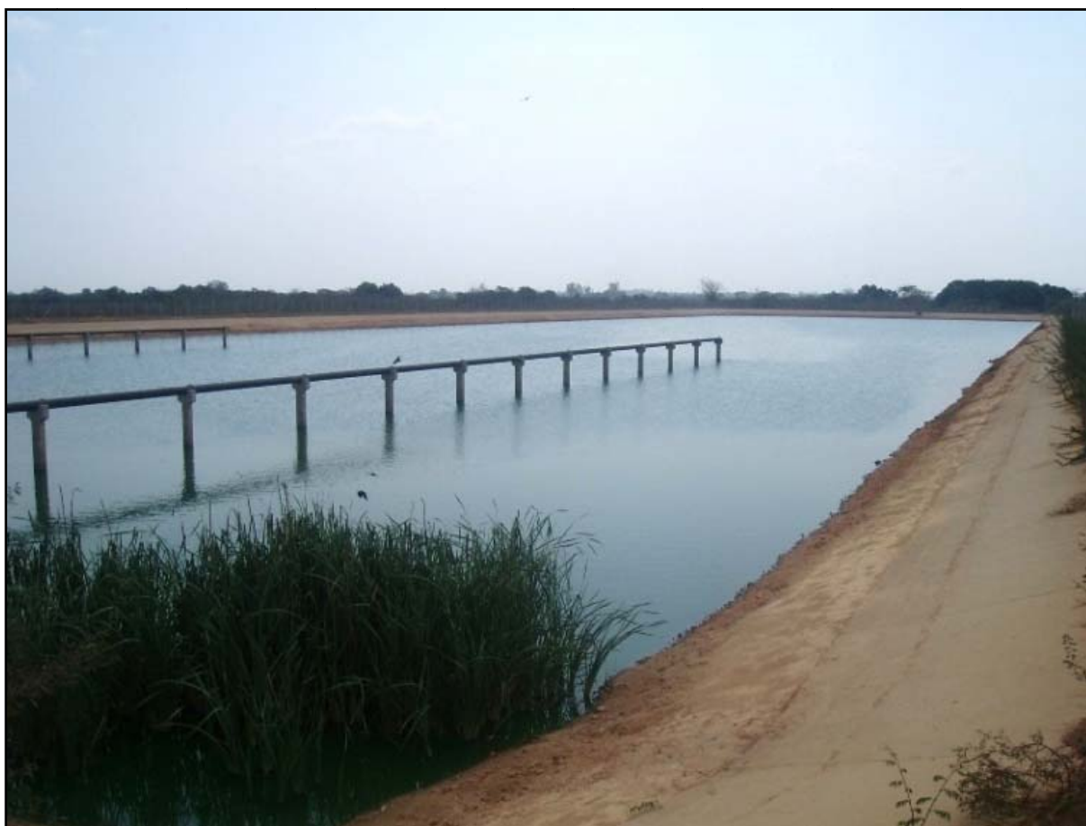
Figura 8.7 - Estação de tratamento de esgoto na Bacia Hidrográfica do Rio Pandeiros - SF9(Fonte: Relatório PAOM - PROAGUA 2007).
