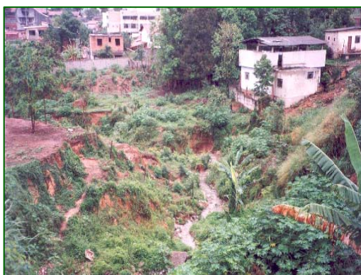
Situação antes das obras
