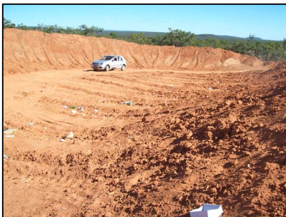
Ibiracatu - Aterro controlado em operação.
