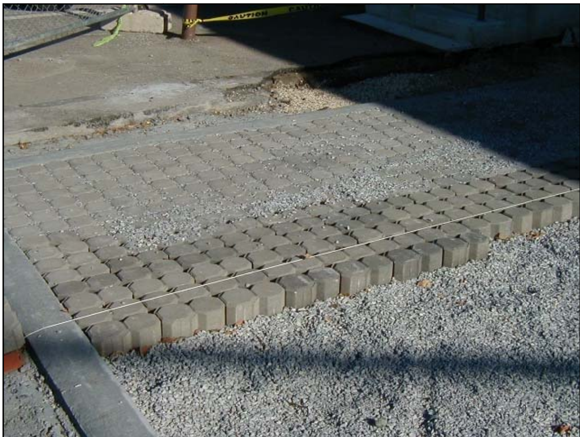
Figura 8.16 - Exemplo de piso poroso para permitir a captura e infiltração de água de chuva. (Fonte: Anacostia Watershed Society - USA).
