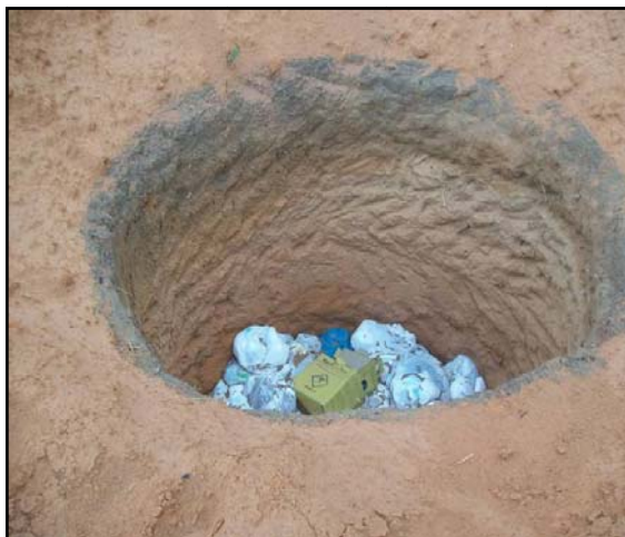
Chapada Gaúcha - Vala para resíduos dos serviços de saúde sem revestimento.
