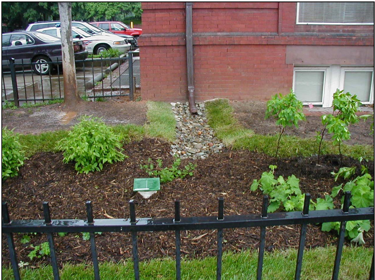
Figura 8.18 - Desconexão do coletor de água pluvial de canaletas de escoamento rápido e encaminhamento a área permeável. (Fonte: Anacostia Watershed Society - USA).
