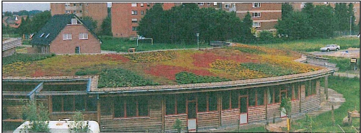
Figura 8.17 - Exemplo de cobertura verde em escola de Stuttgart - Alemanha. (Fonte: Anacostia Watershed Society - USA).
