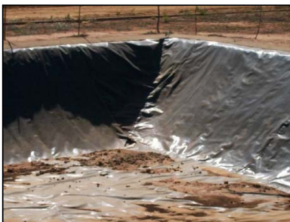
São Francisco - Vala para resíduos.
