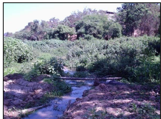
Situação antes das obras
