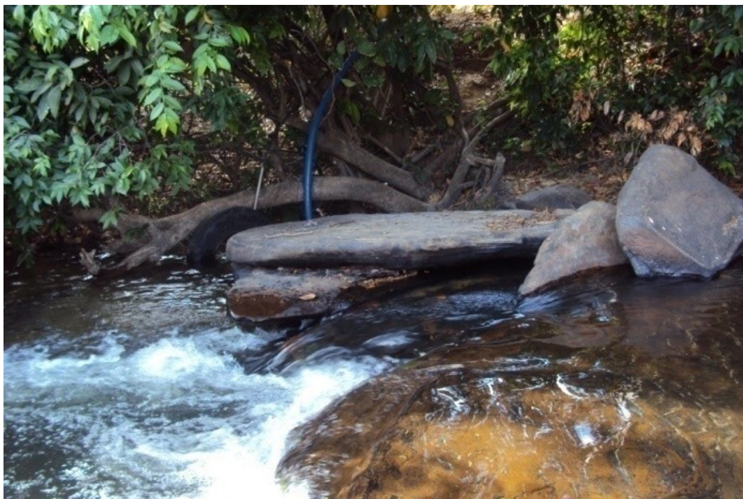
Figura 5.75 - Captação para abastecimento da localidade de Santa Cruz, no riacho das Tabocas. Fonte: Consórcio Ecoplan-Lume-Skill, 2011.
