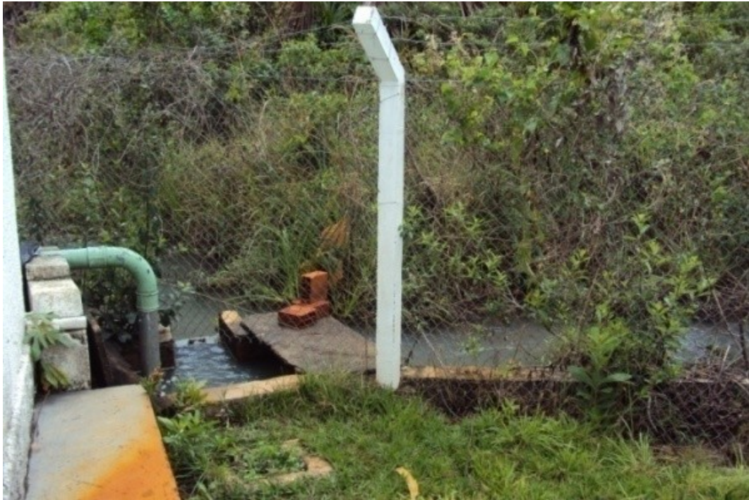
Figura 5.22 - Captação realizada pela COPASA para abastecimento público de Goiásminas, na vereda Lavagem em Formoso. Fonte: Consórcio Ecoplan-Lume-Skill, 2011.
