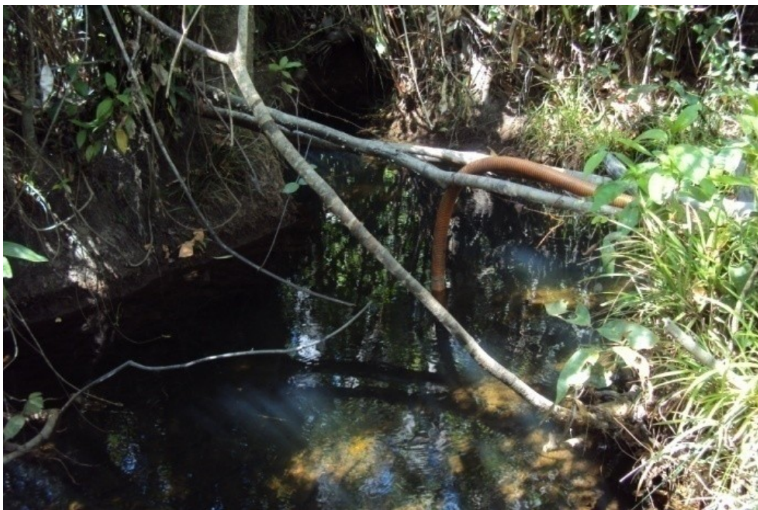
Figura 5.71 - Captação para consumo humano sem tratamento para a localidade Barreirinho, na vereda da Cuia. Fonte: Consórcio Ecoplan-Lume-Skill, 2011.
