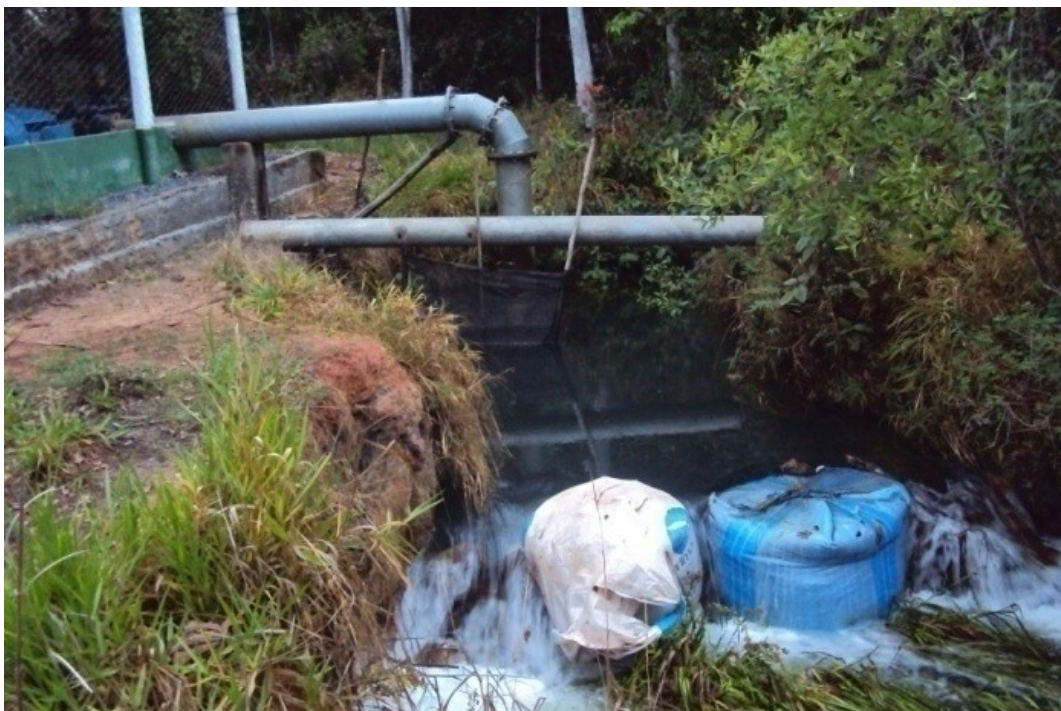
Figura 5.89 - Captação superficial no ribeirão Santo André para irrigação com sistema de pivô central. Fonte: Consórcio Ecoplan-Lume-Skill, 2011.
