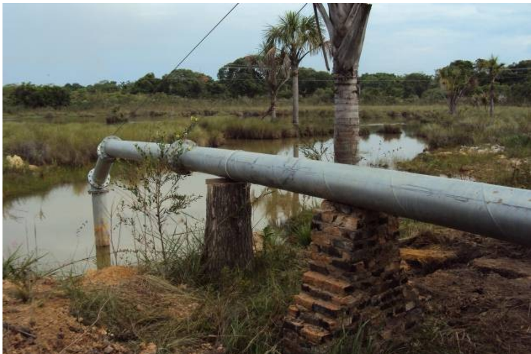
Figura 5.37 - Captação para irrigação as margens do lago em meio a sede urbana de Formoso. Fonte: Consórcio Ecoplan-Lume-Skill, 2011.
