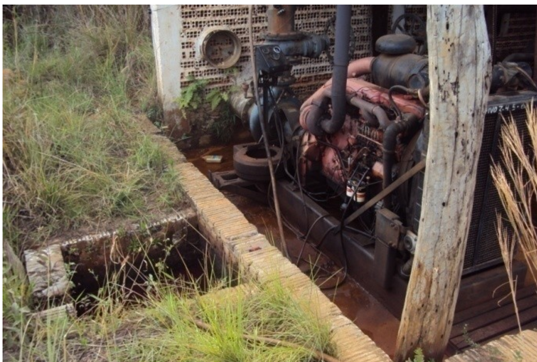
Figura 5.80 - Conjunto moto-bomba utilizado para captação do sistema de irrigação. Detalhe para os vazamentos de óleo, cujo direcionamento é dado para o solo. Fonte: Consórcio Ecoplan-Lume-Skill, 2011.
