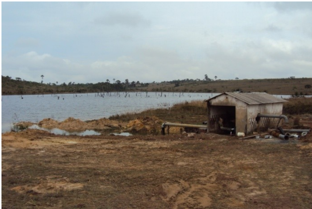
Figura 5.20 - Captação para uso de irrigação com pivô central, no rio Ponte Grande em Formoso. Fonte: Consórcio Ecoplan-Lume-Skill, 2011.
