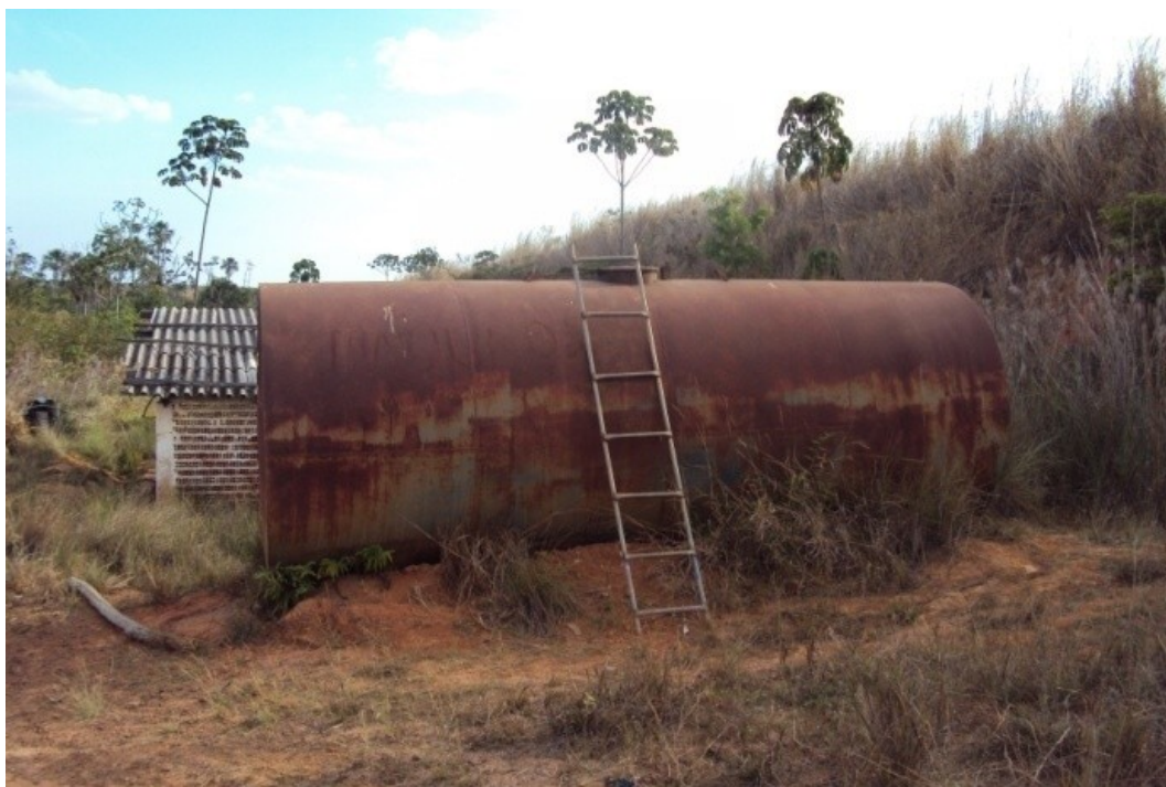
Figura 5.81 - Tanque de armazenamento de combustível (diesel) para os conjuntos moto-bombas. Fonte: Consórcio Ecoplan-Lume-Skill, 2011.
