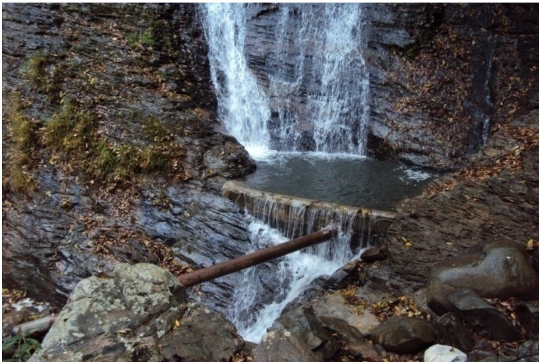
Figura 5.59 - Captação para abastecimento público do distrito Sagarana. Fonte: Consórcio Ecoplan-Lume-Skill, 2011.
