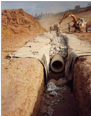
Figura 9.44 - Aterro Sanitário impermeabilização e tubulação de drenagem.
