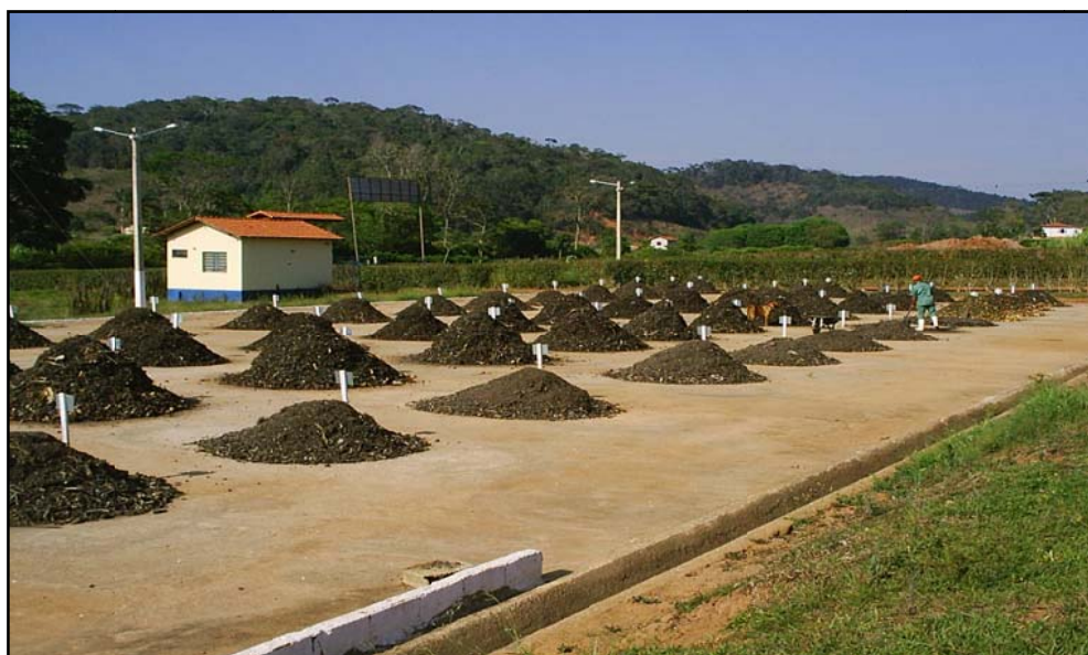
Figura 8.8 - UTC - Unidade de triagem e compostagem – Compostagem de orgânicos. (Fonte: FEAM).
