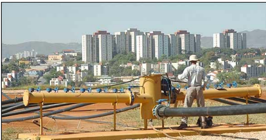
Figura 8.11 - Foto da usina de biogás para eletricidade no aterro da BR 040 em Belo Horizonte (5MW).
