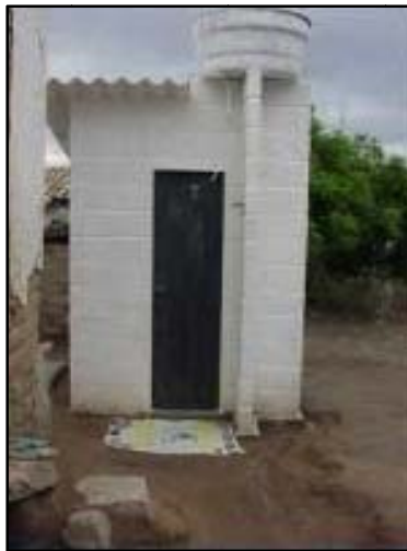
Construção de módulos sanitários
