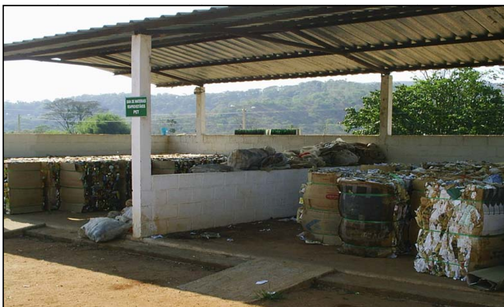
Figura 8.9 - UTC - Unidade de triagem e compostagem – Processamento de recicláveis. (Fonte: FEAM)
