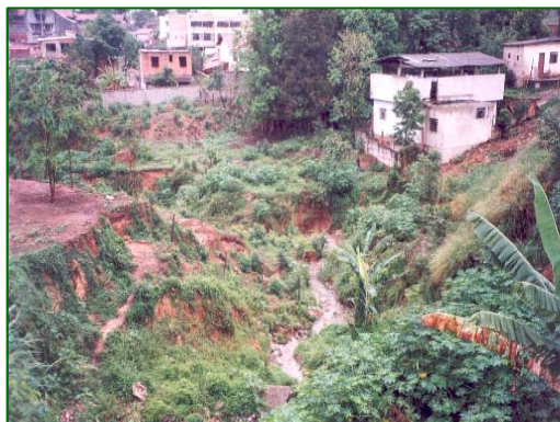
Situação antes das obras
