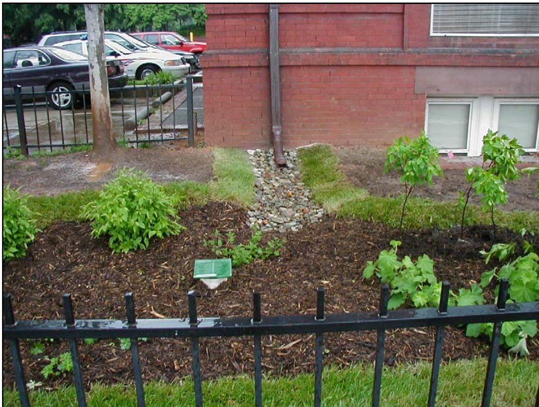
Figura 8.17- Desconexão do coletor de água pluvial de canaletas de escoamento rápido e encaminhamento a área permeável. (Fonte: Anacostia Watershed Society - USA)
