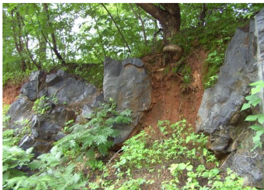
Figura 72 – Deslizamento, na margem da estrada expondo raízes e vegetação
