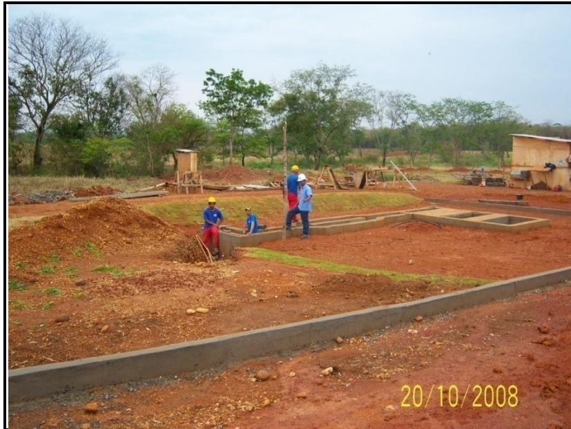
Figura 50 – Estação de Tratamento de Esgotos (Município de Engenheiro Navarro)
