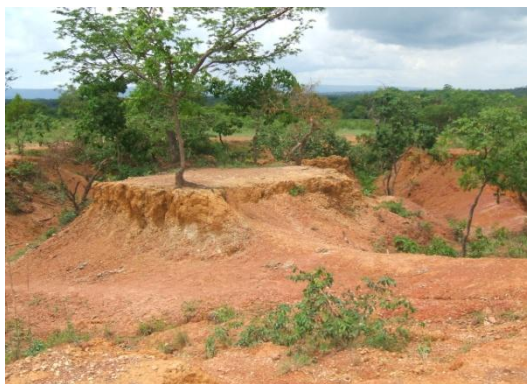
Figura 76 – Voçoroca na margem direita do Córrego Fundo, a 4 km da sua foz com o Rio Jequitaí
