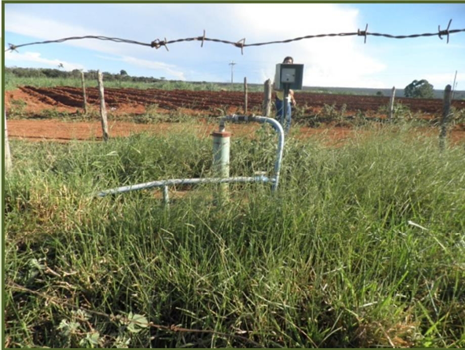
**Figura 52 – Detalhe de poço tubular profundo construído em área de ocorrência dos Depósitos Detrito-lateríticos (NQd). Zona rural de Turmalina.**
