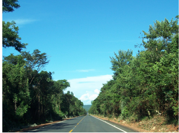
Figura 15 - Chapadão, com vegetação Estacional Semidecidual, cortada pela rodovia entre os municípios de Turmalina e Leme do Prado
