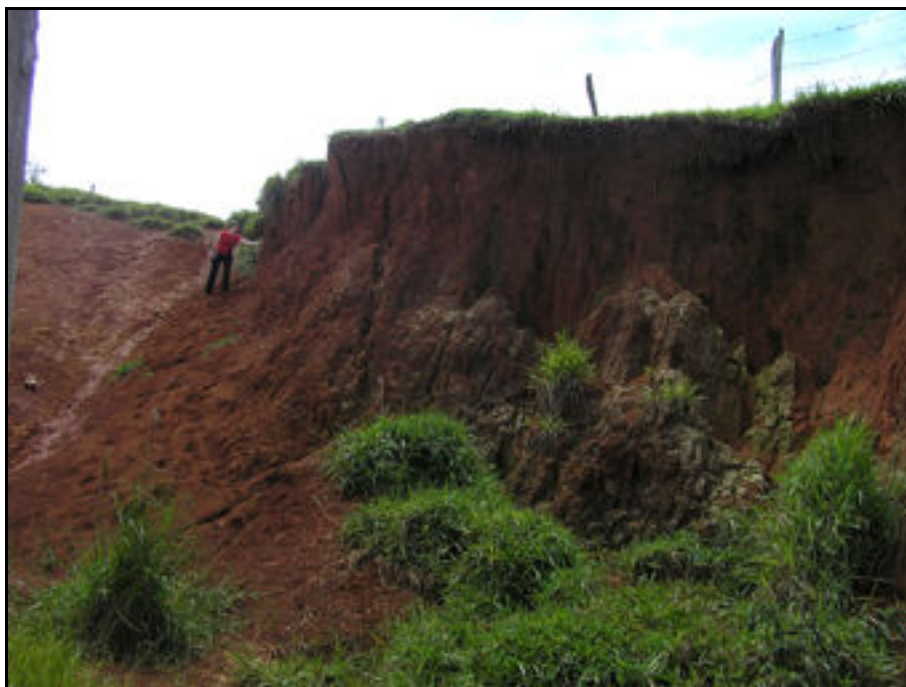
Foto 6 – Aspecto de um corte de estrada em latossolo vermelho-escuro em Elói Mendes.
