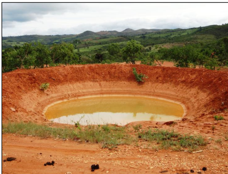
Figura 5.4 – Barraginhas para controle de escoamento
