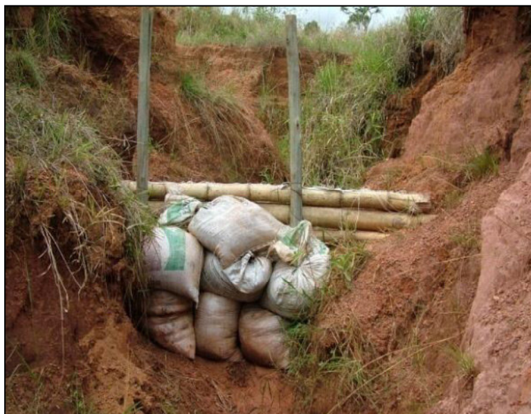
Figura 5.6 – Paliçadas de bambu com sacos de areia para contenção de voçoroca
