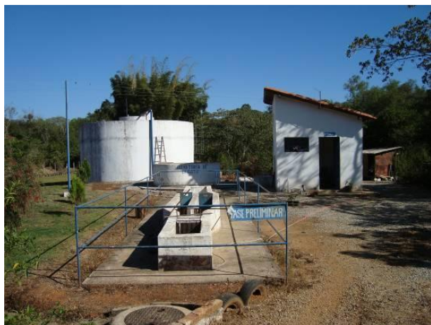
Figura 100 - Estação de tratamento de efluentes da sede municipal de Ibertioga.
