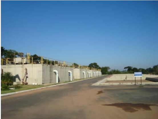
Figura 178 - Estação de tratamento de esgoto da sede municipal de Lavras.
