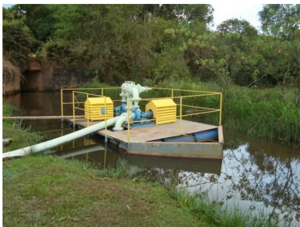
Figura 183 - Ponto de captação para o abastecimento doméstico e industrial da sede municipal de São Bento Abade.
