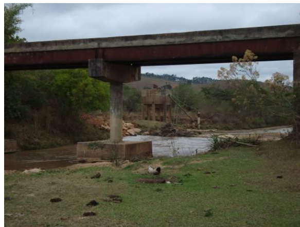
Figura 150 - Futuro ponto de captação para o abastecimento doméstico e industrial da sede municipal de São Tiago.
