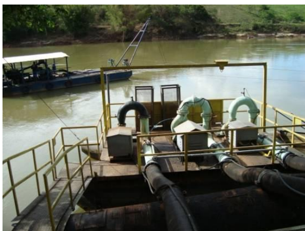
Figura 171 - Ponto de captação para o abastecimento doméstico e industrial da sede municipal de Lavras.
