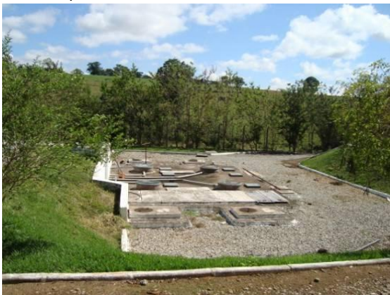
Figura 163 - Estação de tratamento de esgoto da sede municipal de Ijaci.
