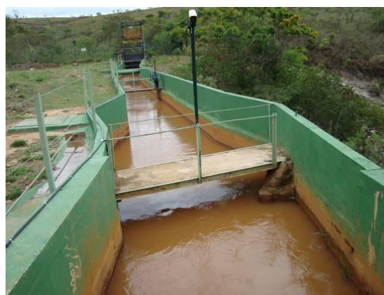
Figura 194 - Ponto de captação para a geração de energia "PCH Luz Boa".
