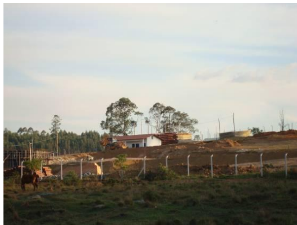
Figura 134 - Obras da estação de tratamento de esgoto da sede municipal de Resende Costa.
