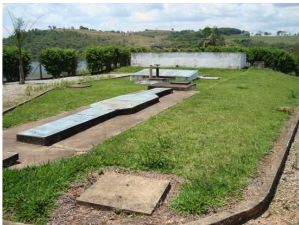
Figura 167 - Estação de tratamento de esgoto do povoado rural Ponte do Funil (Lavras).
