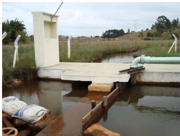
Figura 146 - Ponto de captação para o abastecimento doméstico e industrial da sede municipal de São Tiago.
