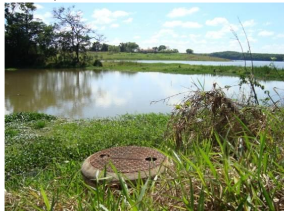
Figura 164 - Ponto de lançamento de esgoto tratado da sede municipal de Ijaci.
