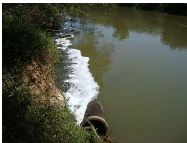
Figura 115 - Ponto de lançamento de efluentes tratados da sede municipal de São João Del Rei (Bairro Colônia do Marçal).
