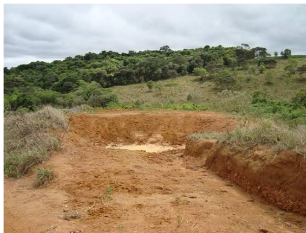
Figura 198 - Pequena barragem construída à margem da estrada vicinal para o acúmulo de água pluvial e sedimentos.
