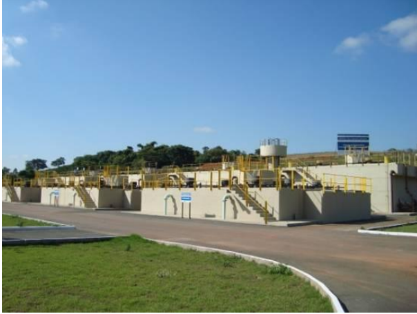
Figura 181 - Estação de tratamento de efluentes da sede municipal de Lavras.
