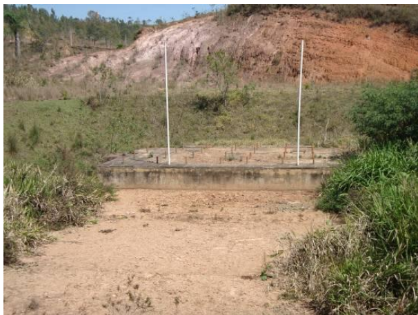
Figura 42 - Estação de tratamento de esgoto da sede municipal de Barbacena trata aproximadamente 5% dos efluentes.
