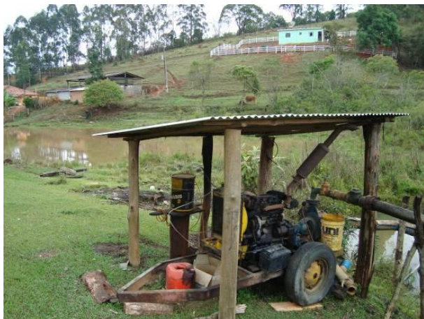
Figura 89 – Captação para a irrigação de olerícolas.
