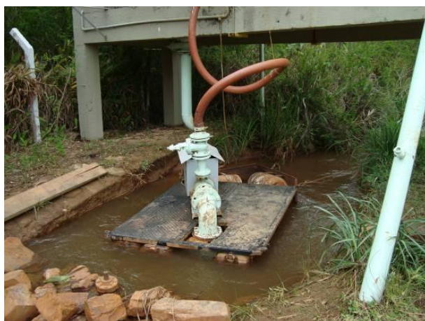
Figura 155 - Em destaque a captação para abastecimento doméstico do distrito Mercês de Água Limpa (São Tiago).
