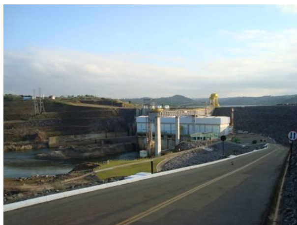
Figura 172 - Usina Hidrelétrica Funil.
