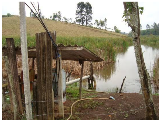
Figura 79 - Ponto de captação para irrigação tipo aspersão (Tomate e repolho.).
