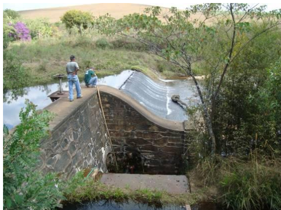
Figura 117 - Ponto de captação para abastecimento doméstico e industrial da sede municipal de São João Del Rei (Barragem do 14).
