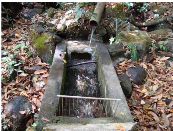
Figura 125 - Ponto de captação para o abastecimento doméstico e industrial da sede municipal de Santa Cruz de Minas.
