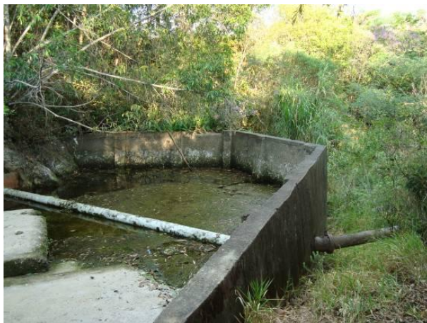
Figura 126 - Ponto de captação para abastecimento doméstico e industrial da sede municipal de São João Del Rei.
