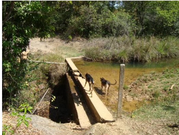
Figura 144 - Ponto de captação para o abastecimento doméstico do distrito de São Sebastião da Vitória.
