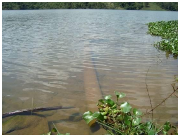
Figura 168 - Ponto de lançamento de esgoto tratado do povoado rural Ponte do Funil (Lavras).
