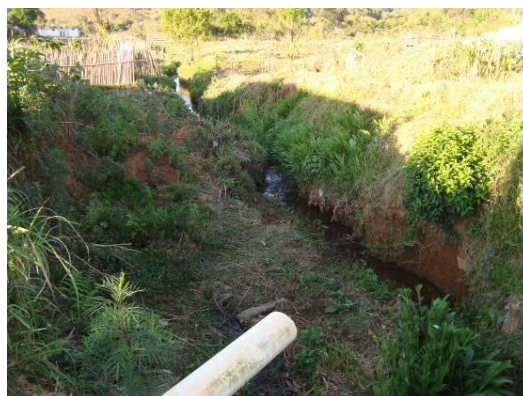
Figura 106 - Ponto de lançamento de efluentes domésticos da sede municipal de Santa Rita do Ibitipoca.
