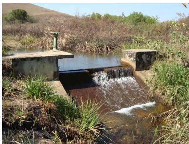
Figura 85 - Captação para abastecimento doméstico e industrial da sede municipal de Carandaí.
