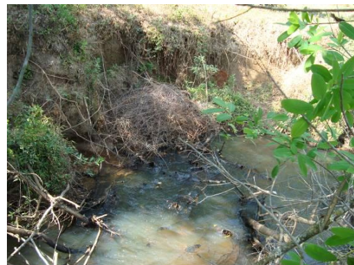
Figura 111 - Ponto de lançamento de efluentes domésticos do distrito de Emboabas (São João Del Rei).
