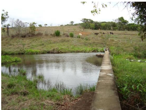
Figura 197 - Ponto de captação para o abastecimento doméstico e industrial da sede municipal de Oliveira.
