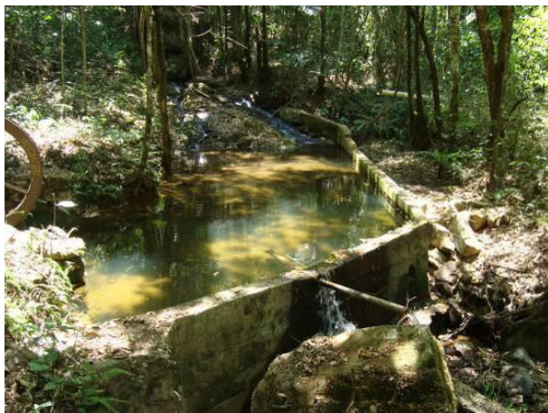
Figura 75 - Ponto de captação para o abastecimento doméstico e industrial da localidade rural de Bichinho (Prados).
