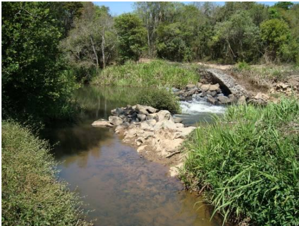
Figura 24 - Ponto de captação para abastecimento doméstico e industrial da sede municipal da Barbacena.
