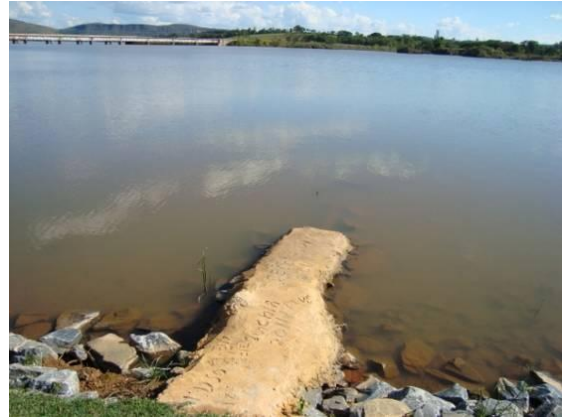
Figura 162 - Ponto de lançamento de esgoto tratado do distrito Macaia.
