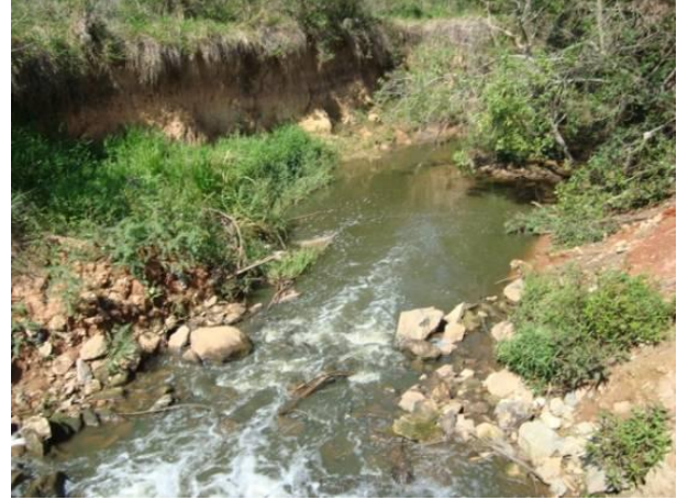
Figura 182 - Ponto de lançamento de efluentes tratados da sede municipal de Lavras.
