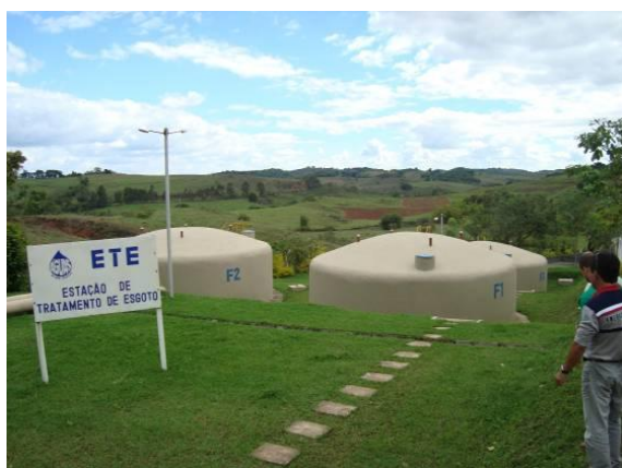
Figura 159 - Estação de tratamento de esgoto da sede municipal de Bom Sucesso.
