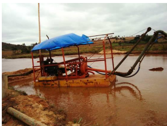
Figura 193 – Dragagem/extração de areia sendo executada no rio Jacaré.
