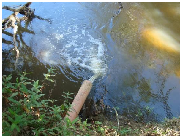
Figura 101 - Lançamento de esgoto tratado da sede municipal de Ibertioga.
