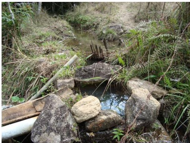
Figura 127 - Ponto de captação para o abastecimento doméstico da localidade rural Ribeirão Santo Antônio (Resende Costa), localizado no ribeirão de Cima.
