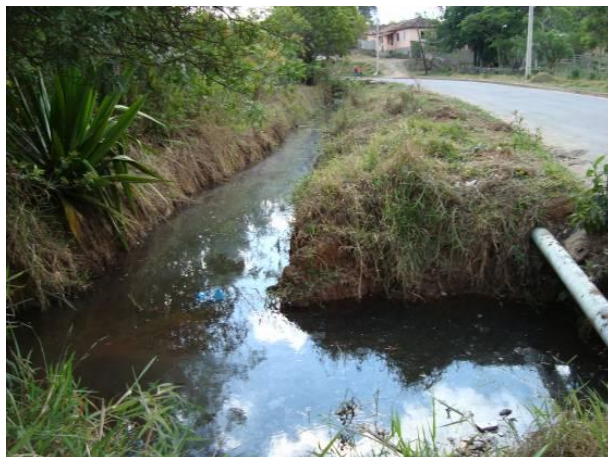
Figura 136 - Ponto de lançamento de efluentes domésticos e industriais provenientes da sede municipal de Ritápolis.
