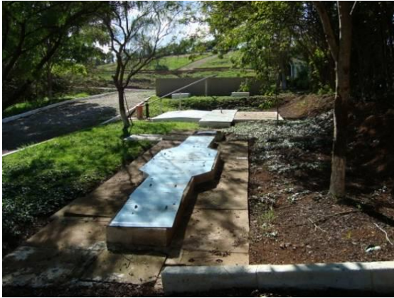
Figura 161 - Estação de tratamento de esgoto do distrito Macaia (Bom Sucesso).
