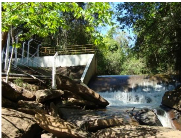
Figura 190 - Ponto de captação para o abastecimento doméstico e industrial de sede municipal de Carmo da cachoeira.
