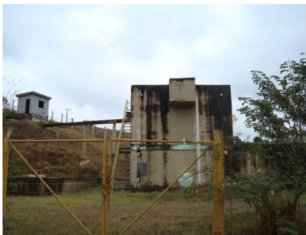
Figura 28 - Estação de tratamento de esgoto da sede municipal de Barroso trata aproximadamente 10 % dos efluentes da sede municipal. Fonte: Ecoplan-Lume-Skill, 2011.
