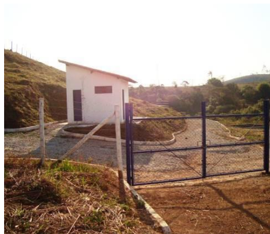
Figura 64 - Estação de tratamento de esgoto de Ressaquinha.
