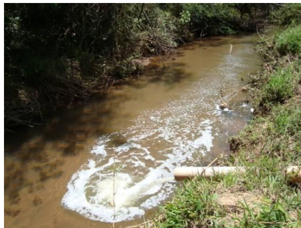
Figura 213 - Ponto de lançamento de efluentes tratados.
