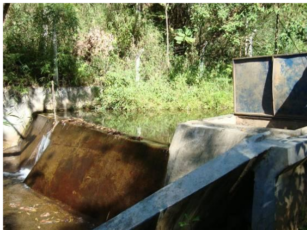
Figura 104 - Ponto de captação para abastecimento doméstico da sede municipal de Santa Rita do Ibitipoca.
