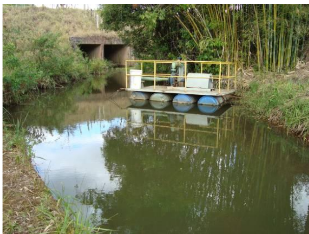
Figura 137 - Em destaque balsa de captação para abastecimento doméstico e industrial da sede municipal de Ritápolis.
