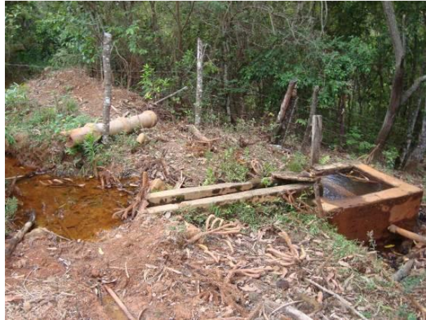
Figura 145 - Captação para abastecimento doméstico do povoado rural Jorge (São Tiago).
