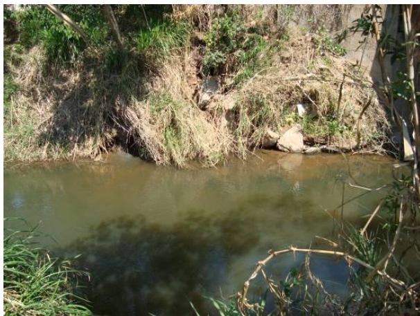
Figura 60 - Ponto de lançamento de efluentes domésticos e industriais da sede municipal de Alfredo Vasconcelos.
