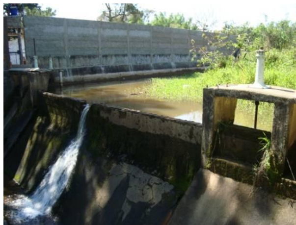
Figura 180 - Ponto de captação para o abastecimento doméstico e industrial da sede municipal de Lavras.
