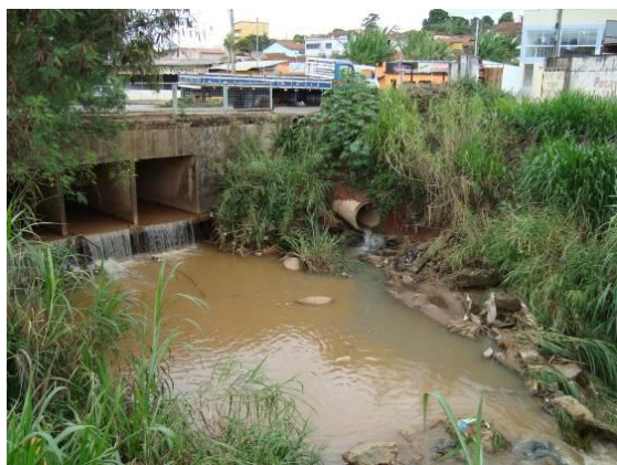
Figura 203 - Ponto de lançamento de efluentes domésticos e industriais da sede municipal de Oliveira.
