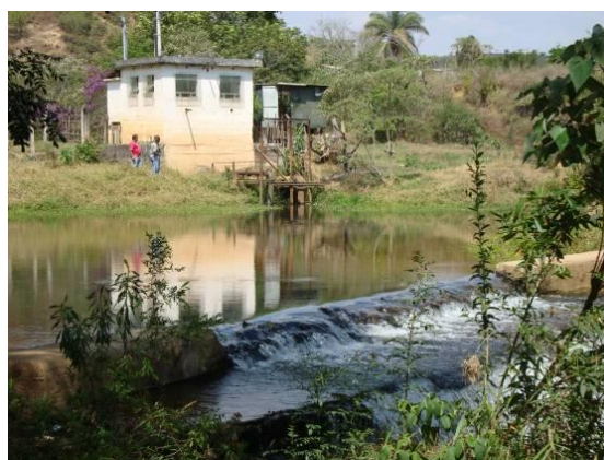
Figura 119 - Captação para abastecimento doméstico e industrial da sede municipal de São João Del Rei.
