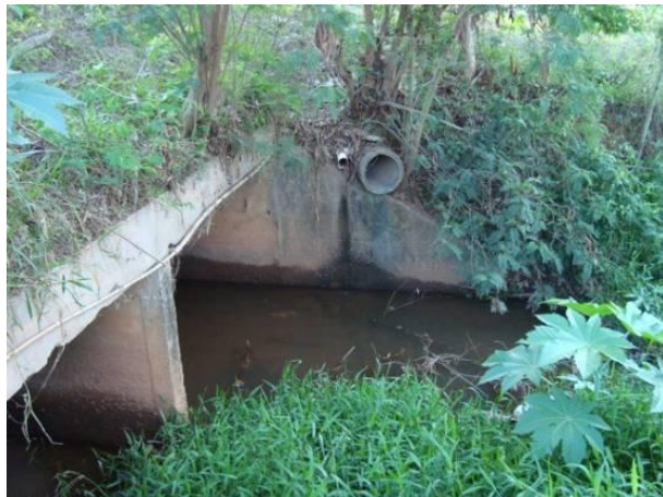
Figura 220 - Ponto de lançamento de efluentes domésticos do distrito de São Sebastião da Estrela (Santo Antônio do Amparo).
