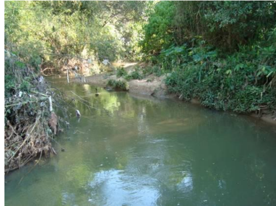
Figura 179 - Ponto de lançamento de efluentes tratados da sede municipal de Lavras.
