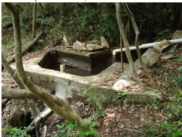
Figura 129 - Ponto de captação para o abastecimento doméstico da localidade rural Pintos (Resende Costa), localizado no ribeirão dos Marianos.
