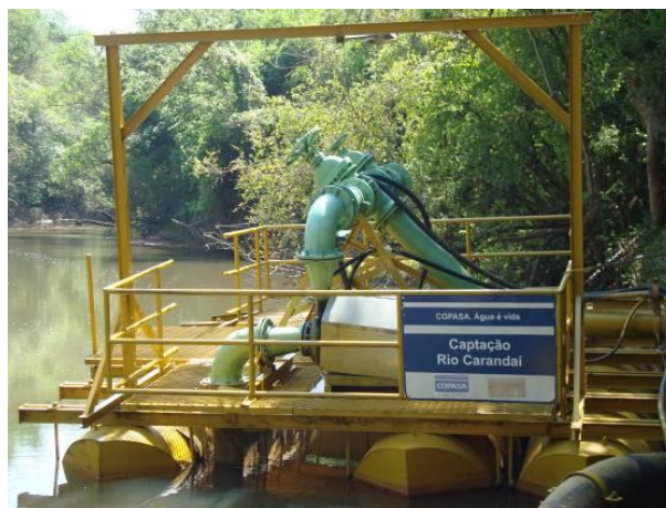
Figura 83 - Em destaque balsa de captação para o abastecimento doméstico e industrial de São João Del Rei e das localidades rurais de Cesar de Pina e Águas Santas ambas pertencentes a Tiradentes. Fonte: Ecoplan-Lume-Skill, 2011.
