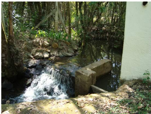
Figura 86 - Ponto da captação para abastecimento doméstico do distrito de Pedra do Sino (Carandaí).
