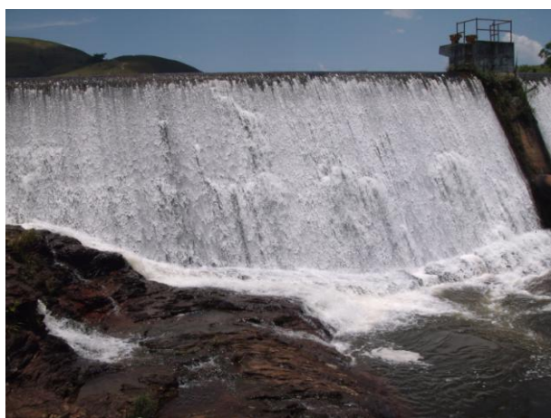
Figura 139 – Usina dos Moinhos, localizada no ribeirão Barba de Lobo.
