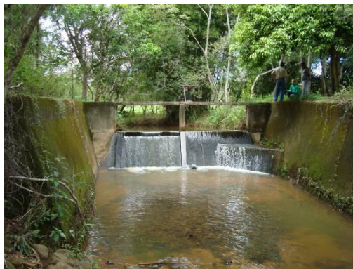
Figura 158 - Captação para o abastecimento doméstico e industrial da sede municipal de Bom Sucesso.
