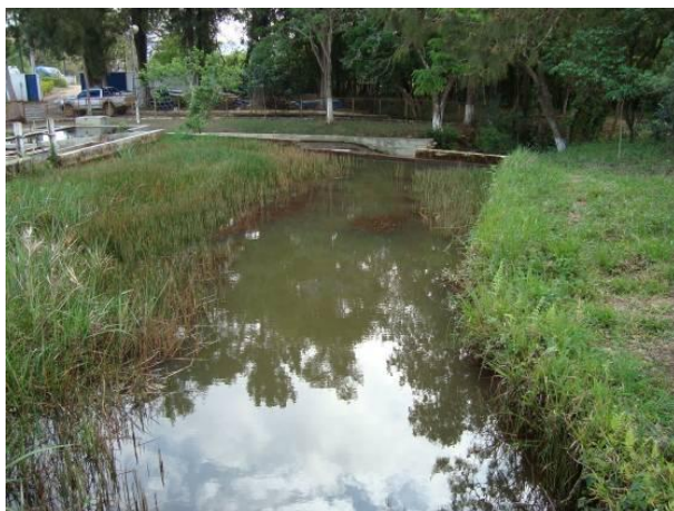
Figura 53 - Captação para o abastecimento doméstico e industrial da sede municipal de Barroso.
