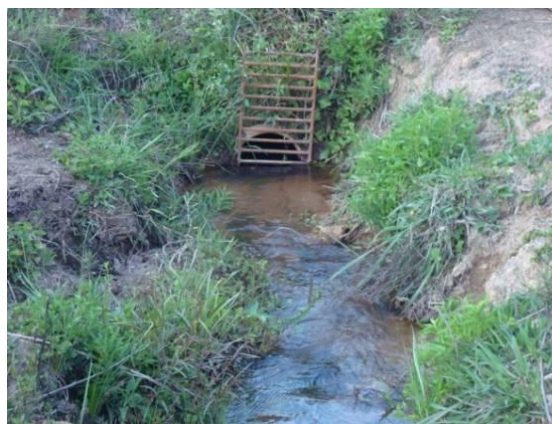
Figura 219 - Ponto de captação para o abastecimento doméstico do distrito São Sebastião da Estrela (Santo Antônio do Amparo).
