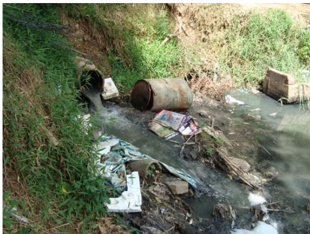
Figura 112 - Ponto de lançamento de efluentes domésticos e industriais da sede municipal de Santa Cruz de Minas.
