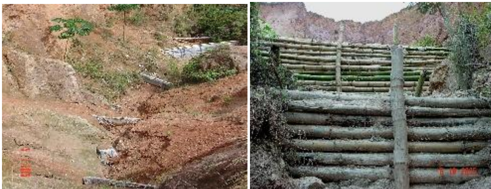
Figura 91 - Paliçadas de bambu implantadas na área interna da voçoroca.
