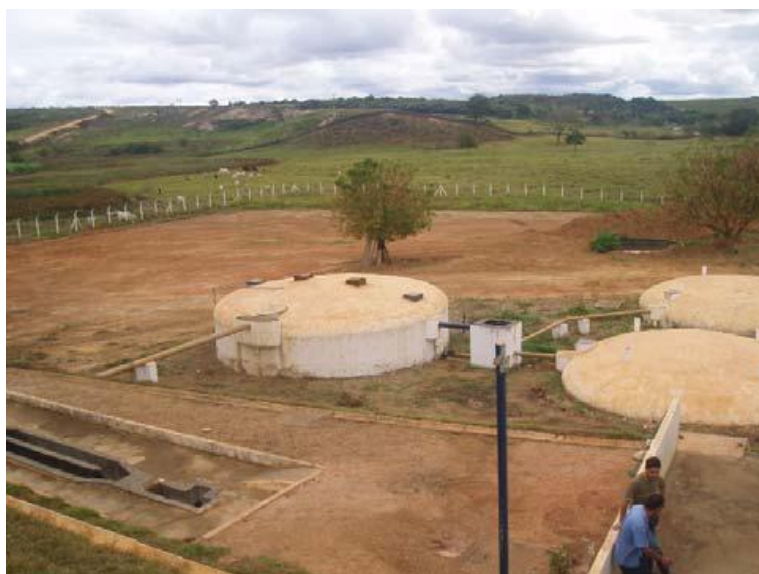
Figura 62 – Exemplo de Estação de Tratamento de Esgotos RAFA – Filtros - Localidade Machado Mineiro – MG
