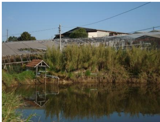
Figura 23 - Captação para irrigação de flores
