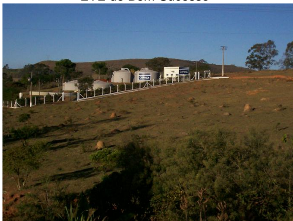
ETE Colônia do Marçal – São João Del Rei
