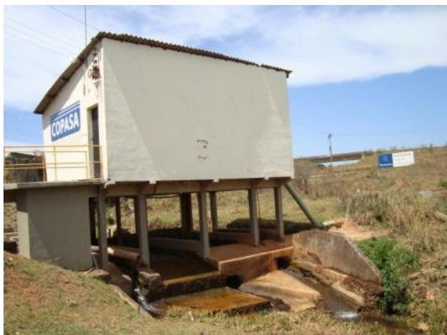
Figura 22 - Captação para abastecimento do doméstico da sede de Barbacena
