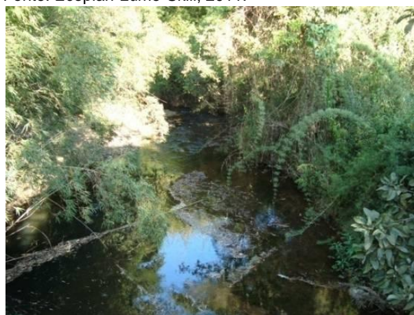
Figura 117 - Ponto de lançamento de efluentes domésticos do distrito de Santo Antônio do Porto (Piedade do Rio Grande).
