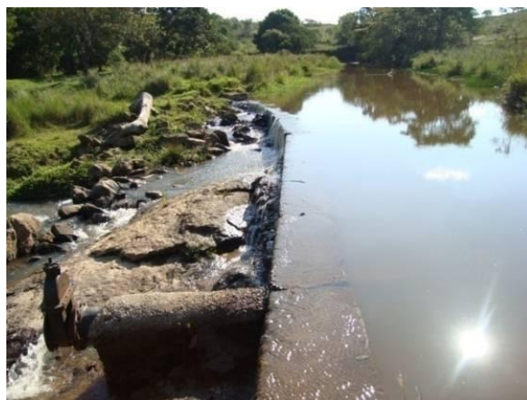
Figura 95 - Ponto de captação para abastecimento público da sede municipal de Itumirim.
