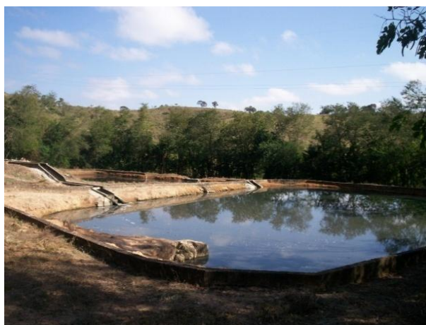
Figura 144 – ETE Rio Grande.
