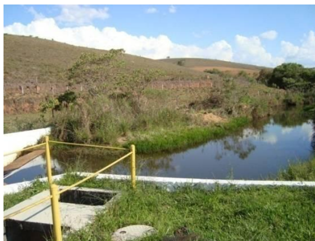
Figura 75 - Ponto de captação para o abastecimento doméstico e industrial da sede municipal de Cruzília.
