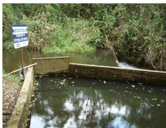
Figura 107 - Ponto de captação para abastecimento doméstico e industrial da sede municipal de Bom Jardim de Minas.
