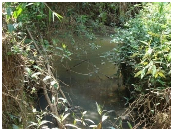
Figura 69 - Ponto de lançamento de esgoto tratado da sede municipal de Minduri.
