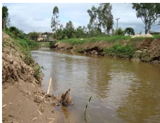
Figura 52 – Ponto de lançamento de esgoto “in natura” da sede de Carvalhos.
