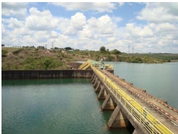
Figura 140 - Barramento Usina Hidrelétrica de Itutinga.
