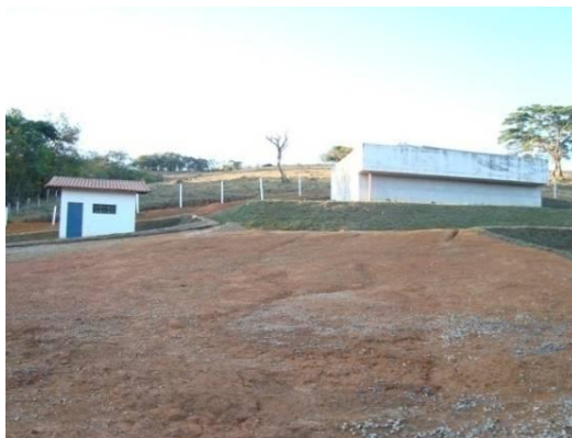
Figura 122 - Em destaque a estação de tratamento de efluentes do município de Piedade do Rio Grande.
