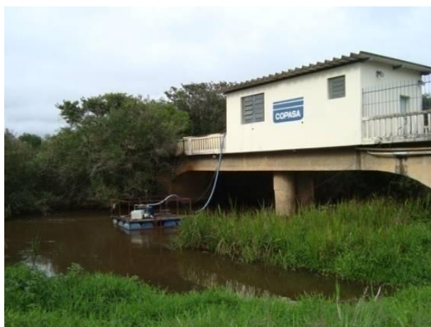
Figura 96- Captação para abastecimento doméstico e industrial da sede municipal de Liberdade.
