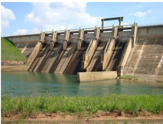
Figura 138 - Barramento da Usina Hidrelétrica de Camargos.
