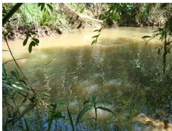
Figura 94 - Ponto de lançamento de esgoto tratado da sede municipal de Lavras.
