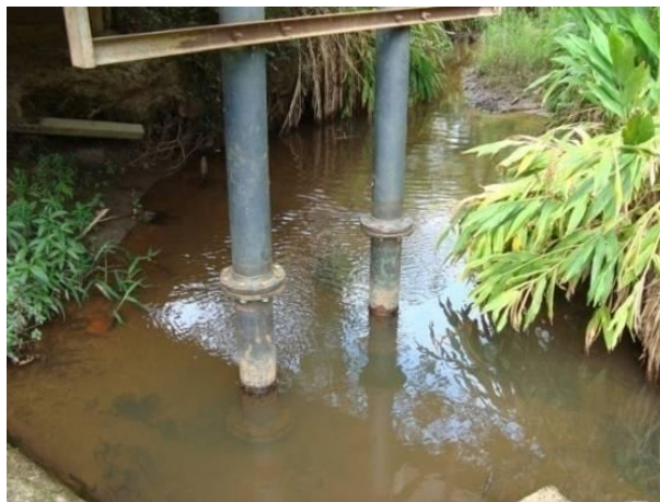
Figura 81 - Ponto de captação para abastecimento público da sede municipal de Ingai.
