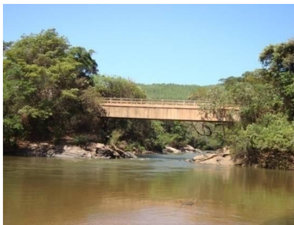
Figura 100 - Ponto destinado a recreação reprimido pelo lançamento de efluentes domésticos da sede municipal de Santana do Garambéu.
