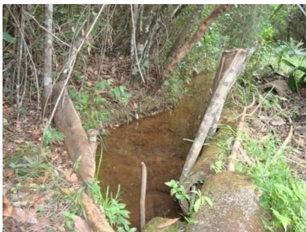
Figura 136 - Ponto de captação para abastecimento doméstico do povoado rural Jaguara (Nazareno).
