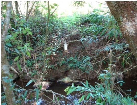
Figura 109 - Ponto de lançamento de efluentes domésticos do distrito de Conceição de Ibitipoca (Lima Duarte).
