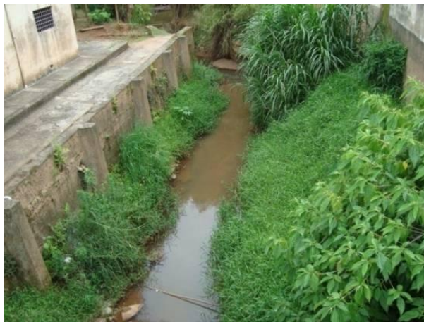
Figura 46 - Ponto de lançamento de esgoto "in natura" da sede municipal de Aiuruoca (córrego da Campina).
