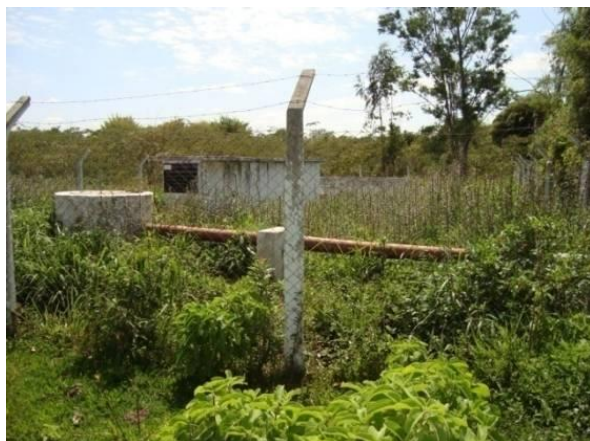
Figura 68 - Estação de tratamento de esgoto da sede municipal de Minduri.
