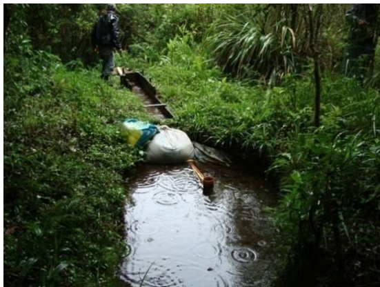
Figura 101 - Ponto de captação para abastecimento público do povoado rural de Santo Antônio do Rio Grande (Bocaina de Minas).
