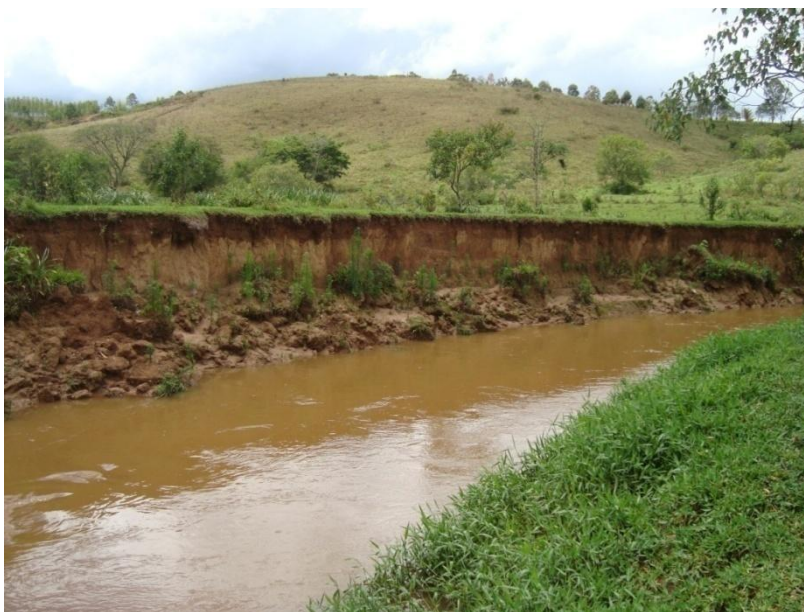
Figura 84 - Margens erodidas em trecho do rio Turvo Pequeno pela utilização para pastoreio de bovinos
