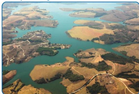
Reservatório de Camargos Produção de energia no Rio Grande
