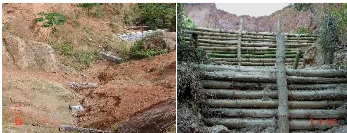
Figura 80 - Paliçadas de bambu implantadas na área interna da voçoroca.
