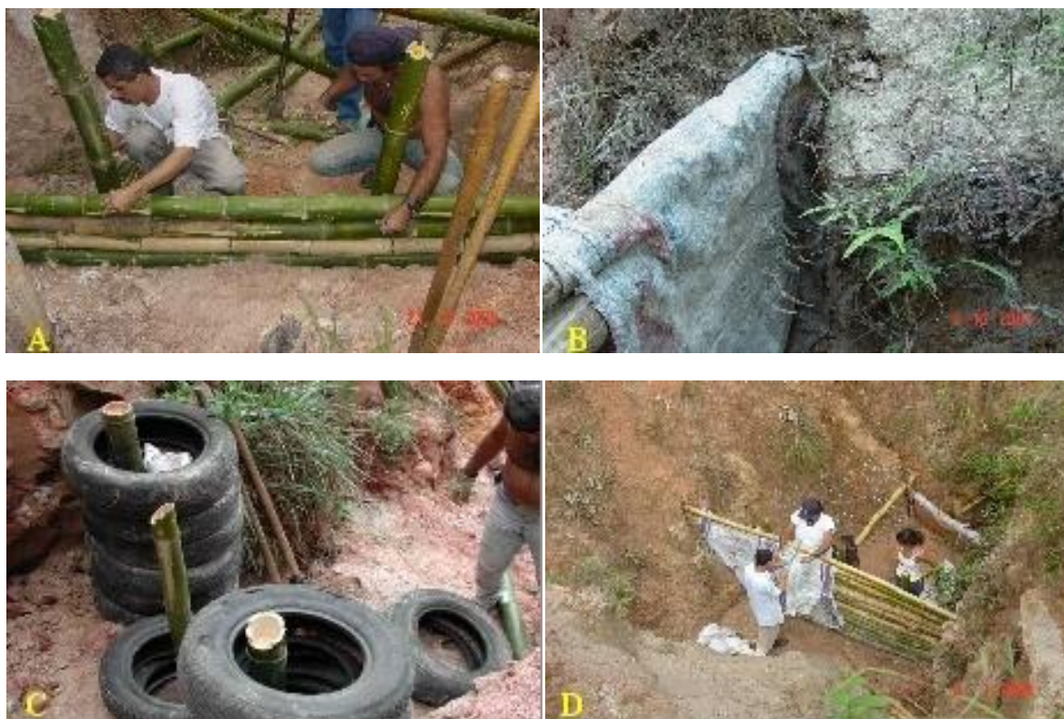
Figura 81 - (A) encaixe canaleta no leito da voçoroca e amarrio dos bambus; (B) Detalhe do encaixe dos bambus no barranco lateral; (C) construção de paliçada utilizando pneus usados; (D) colocação de sacos de ráfia
