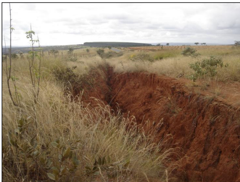
Figura 5.2 – Erosão tipo voçoroca em declividade moderada
