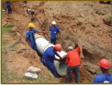
Ampliação da coleta de esgotos sanitários
