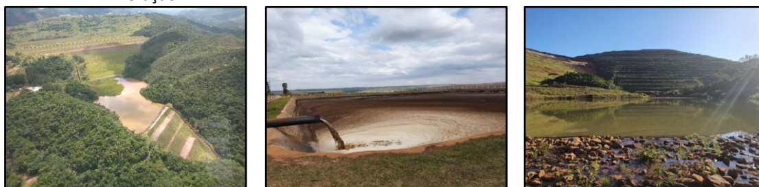
Figura 4 — Barragens de disposição temporária ou final de resíduos e/ou rejeitos da indústria e mineração
