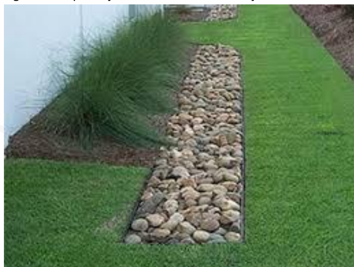
Figura 2 – Implantação de trincheira de infiltração
