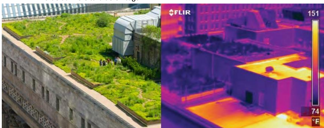
Figura 1 – Comparação da temperatura da superfície entre o telhado sem cobertura e o telhado verde da Prefeitura de Chicago
