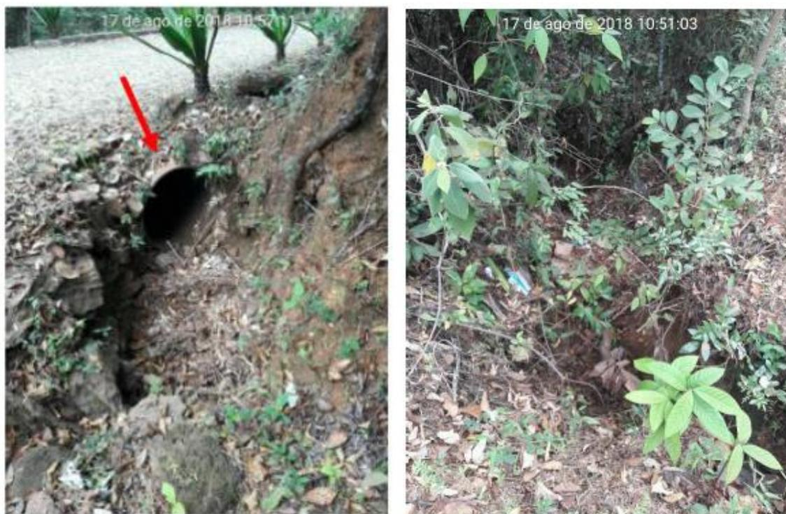
Figura 30 - Erosão linear em Macacos, com destaque para a manilha de drenagem de água pluvial.
