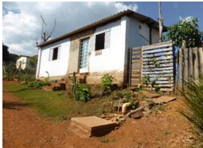
Figura 23 - Ausência de sistema de drenagem em via do distrito de Penedia (Caeté). Portal CBH Rio das Velhas, 2016.
