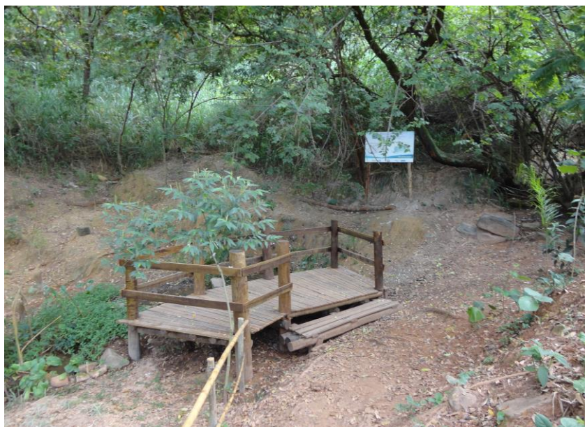
Figura 34 - Deque de madeira construído para valorização de nascente na região do bairro Ribeiro de Abreu. FONTE: Acervo CBH Rio das Velhas, 2016.
