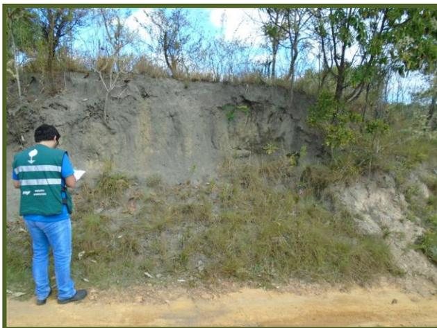
Figura 18 - Técnico inspeciona processo erosivo às margens de estrada no município de Gouveia, bacia do córrego Sepultura. FONTE: MYR, 2015.
