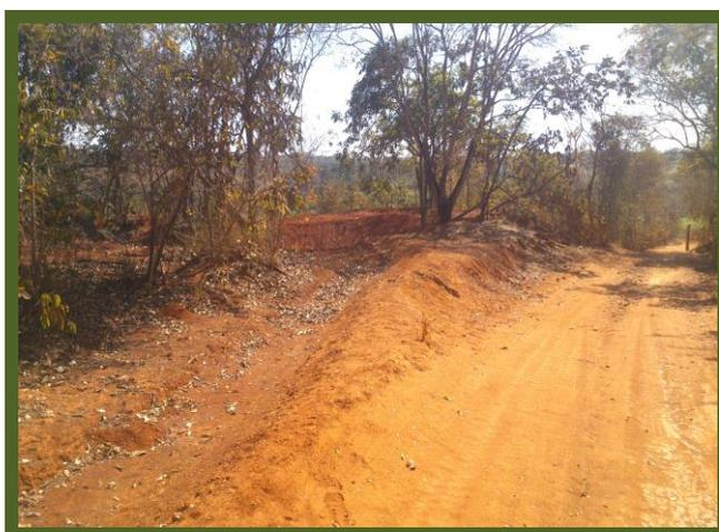
Figura 45 - Barragem construída, com detalhe para o canal de tomada d'água à beira de estrada rural em Corinto. FONTE: AGB Peixe Vivo, 2015.
