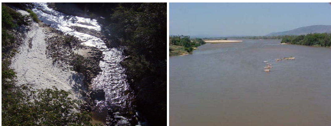
Figura 9.1: Assoreamento no rio Jequitinhonha a jusante de São Gonçalo do Rio das Pedras (JE001) e na cidade de Almenara (JE023).
