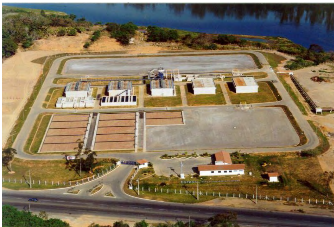
Figura 4.5 Estação de tratamento de esgoto de Ipatinga (ETE IPANEMA).
