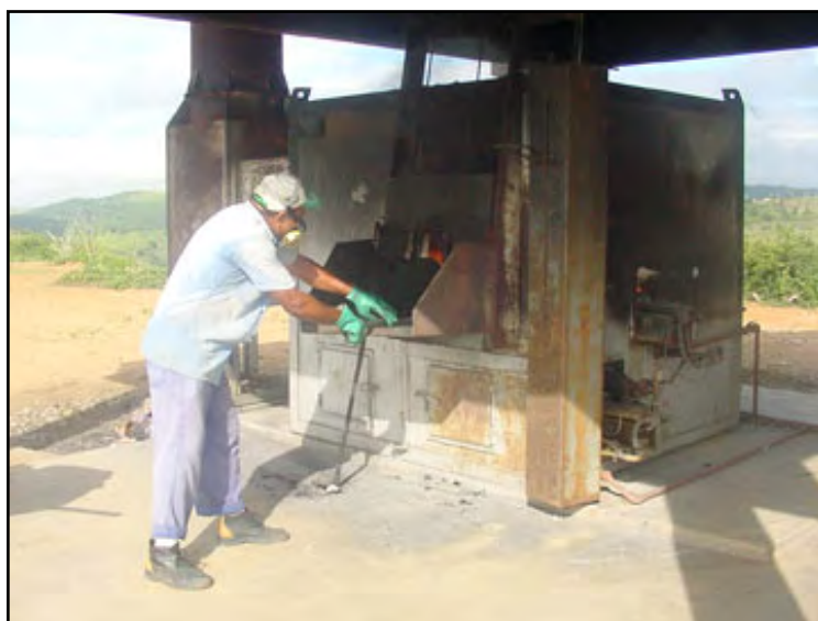
Figura 4.8 Incinerador de resíduos de serviços de saúde da SANEAR em Colatina.
