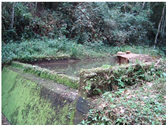
Figura F.10 - Barramento da captação de Itanhadu.
