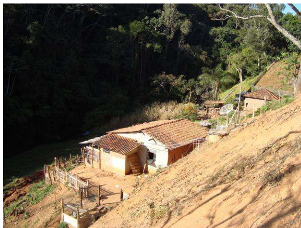
Figura F.135 - Ocupação humana acima do ponto de captação no ribeirão da Glória.
