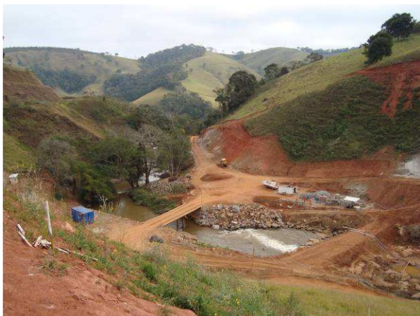
Figura F.138 - Vista da porção jusante do maciço da PCH Cristina.
