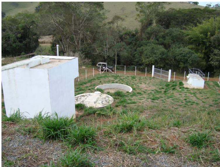
Figura F.6 - ETE do bairro rural Gonçalves ainda não operante.
