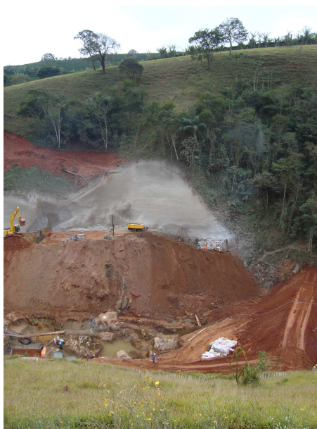
Figura F.137 - Maciço em implantação da PCH Cristina no rio Lambari.
