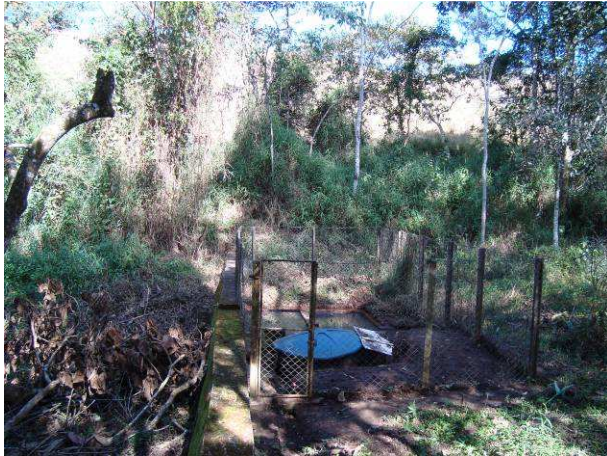
Figura F.109 - Ponto de captação cercado no córrego da Ribeira.
