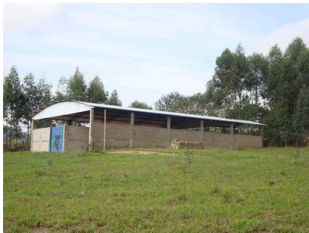
Figura F.108 - Usina de triagem e reciclagem de lixo paralisada no aterro sanitário de Caxambu.
