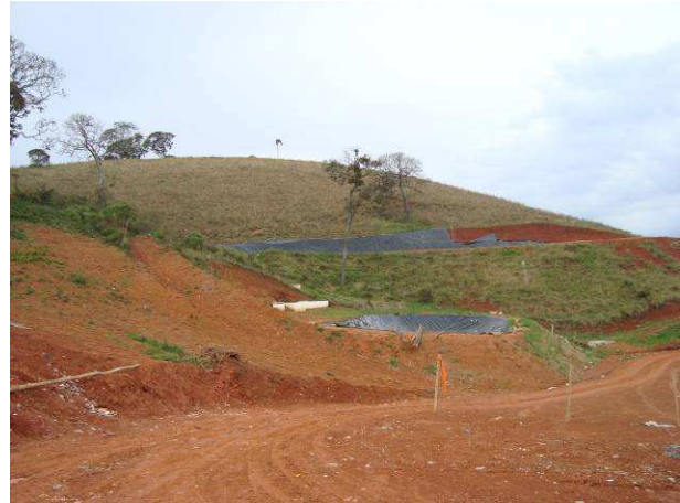
Figura F.9 - Bacias de chorume sendo implantadas para transformação do aterro controlado em aterro sanitário em Itanhadu.
