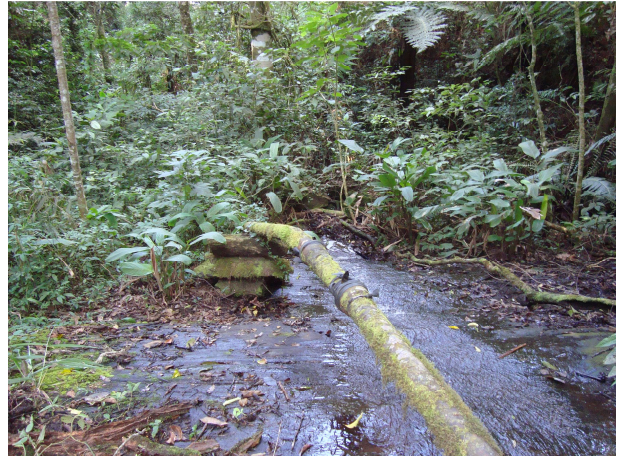
Figura F.148 - Adução em nascente do córrego Werneck na serra da Campanha.
