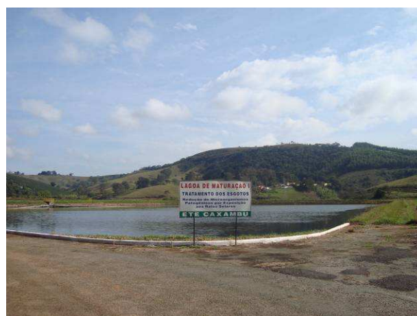
Figura F.104 - Lagoa de tratamento aeróbio da ETE em Caxambu.
