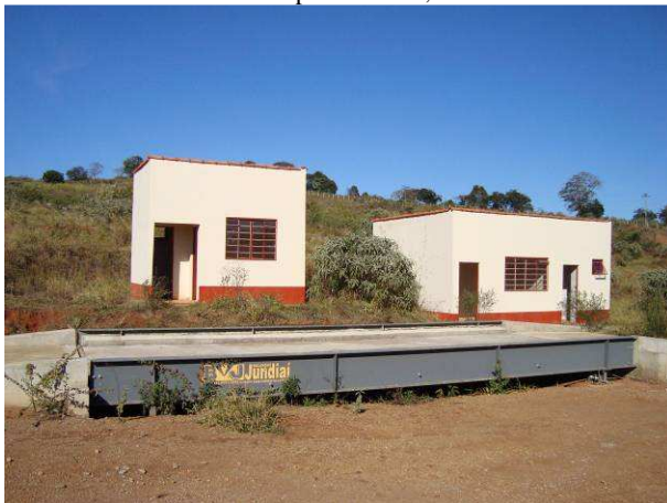
Figura F.194 - Balança para pesagem de caminhões no aterro sanitário abandonado de Varginha.
