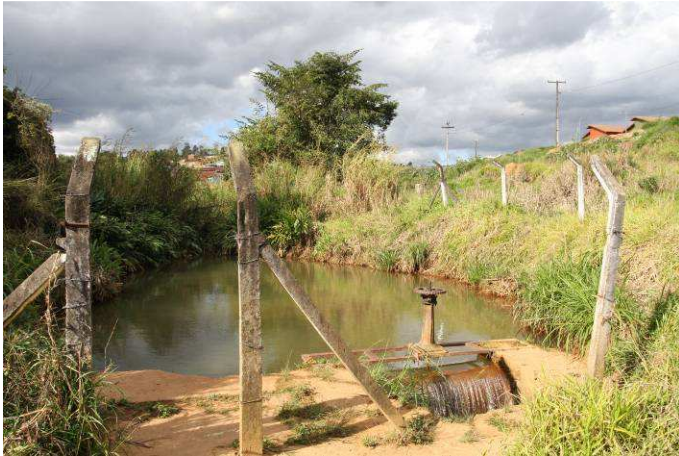
Figura F.119 - Captação no córrego dos Cunhas.
