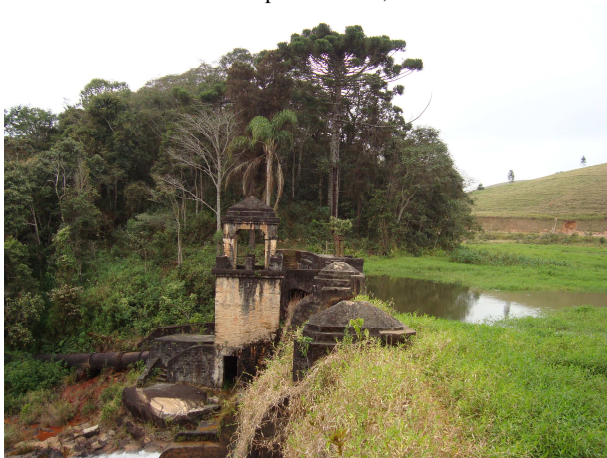
Figura F.53 - Estruturas antigas do barramento da PCH dos Bragas.
