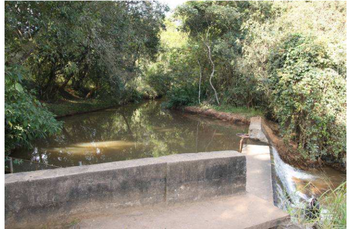
Figura F.120 - Captação no ribeirão Santana.
