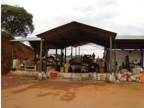
Figura F.8 - Usina de triagem de lixo do aterro controlado de Itanhadu.
