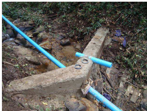
Figura F.159 - Tubulação sendo implantada para adução de água.
