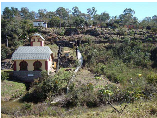
Figura F.169 - Casa de força da PCH Ribeiro ou Usina Velha.
