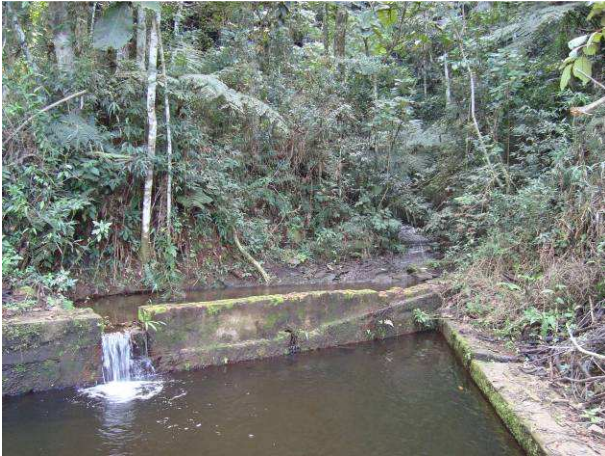
Figura F.147 - Captação em nascente do córrego Werneck na serra da Campanha.
