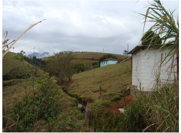
Figura F.30 - Captação do distrito Pé do Morro.
