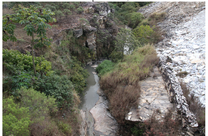
Figura F.176 - Ponto de lançamento de esgoto de São Thomé no córrego Covoca ou da Cachoeira.
