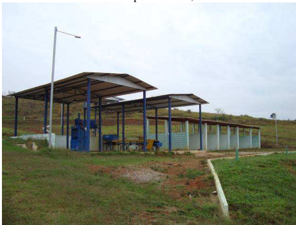
Figura F.47 - Esteira para triagem do lixo e baias laterais da UTC de Itamonte.
