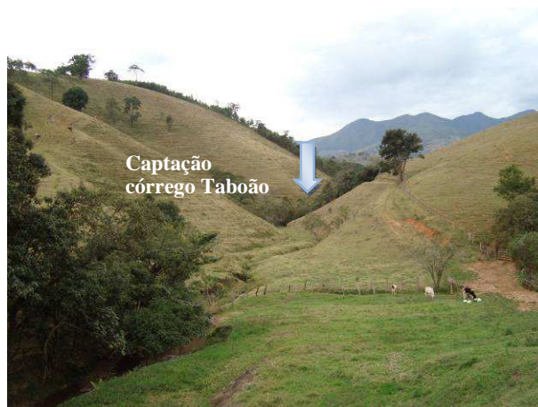
Figura F.35 - Captação emergencial da sede urbana de Passa Quatro.
