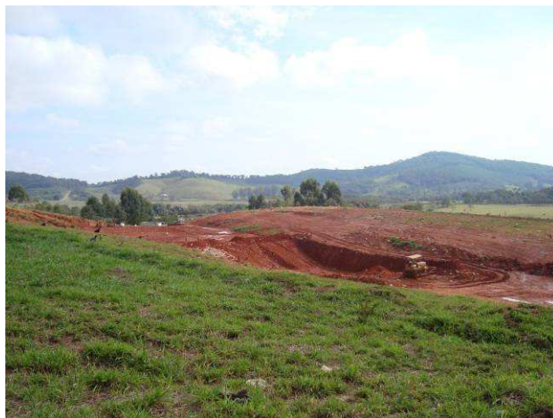
Figura F.106 - Vala de lixo comum do aterro sanitário de Caxambu.
