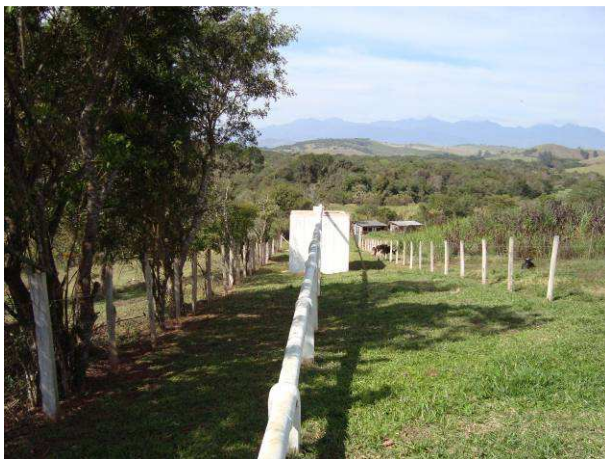
Figura F.14 - Direcionamento do esgoto para tanque anaeróbio da ETE em operação em São Sebastião do Rio Verde.
