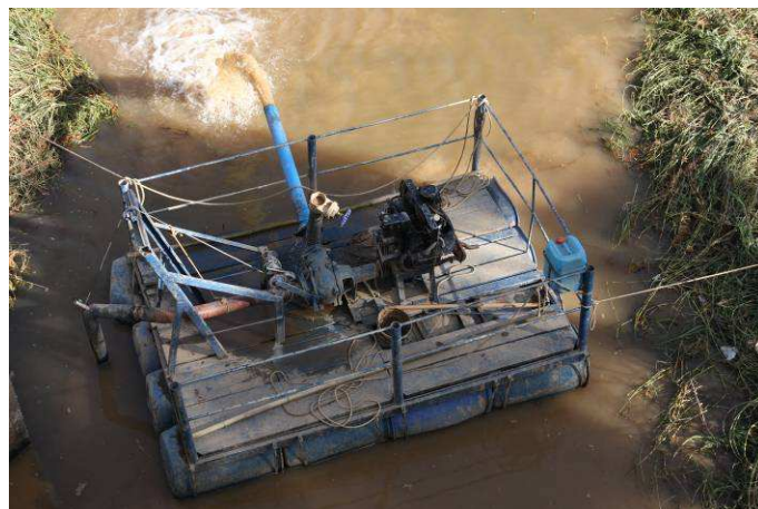
Figura F.116 - Dragagem para melhorar o ponto de captação.
