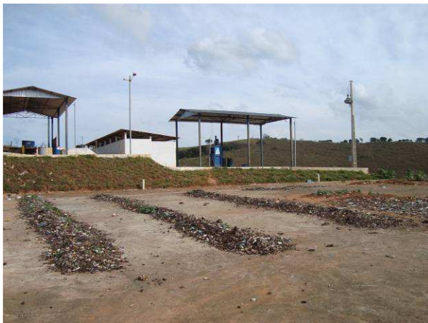
Figura F.52 - Compostagem do lixo orgânico de Pouso Alto com local de triagem ao fundo.
