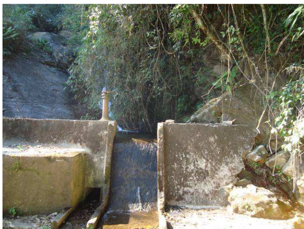
Figura F.55 - Barramento para captação no córrego da Usina.
