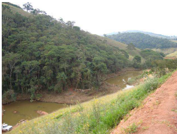
Figura F.139 - Vista da porção montante do maciço da PCH Cristina.
