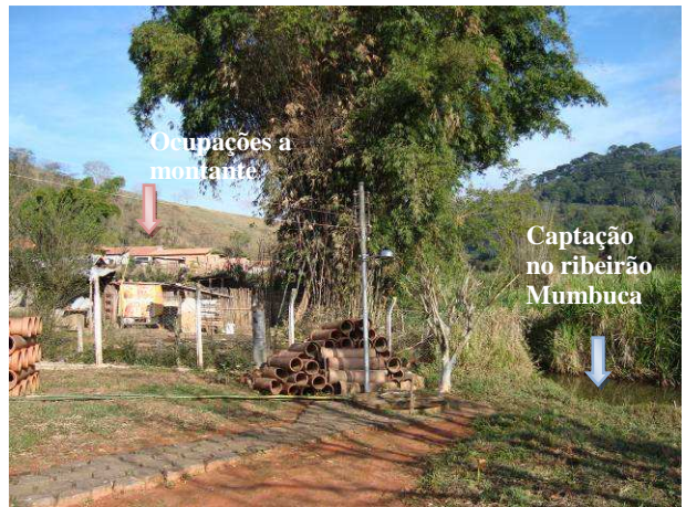
Figura F.150 - Ocupação a montante do ponto de captação do ribeirão Mumbuca.
