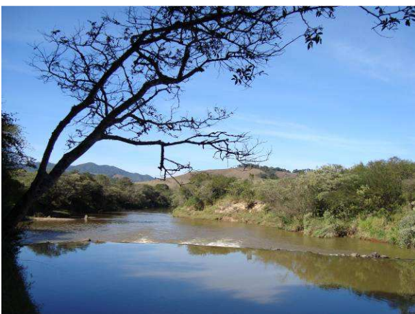
Figura F.71 - Vista para jusante da captação com mata ciliar e o barramento a fio d'água construído.
