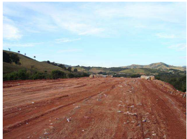
Figura F.87 - Vista geral do aterro.
