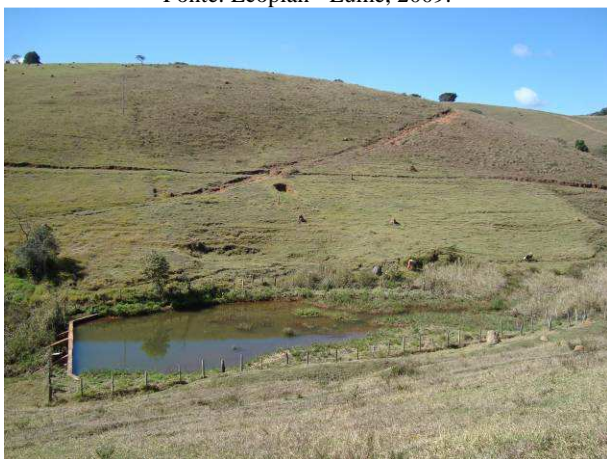
Figura F.83 - Captação cercada no córrego Conquista na sub-bacia do rio Baependi.
