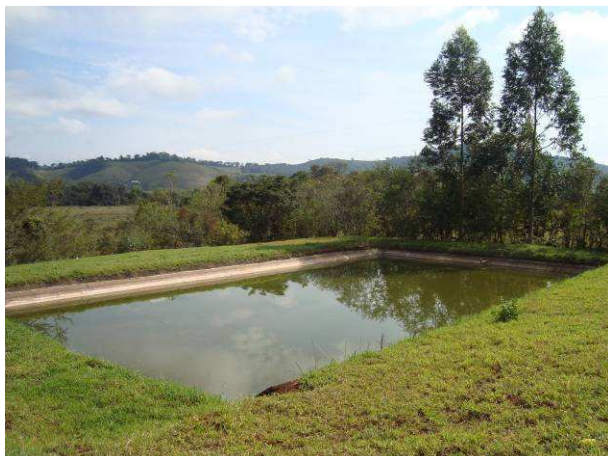
Figura F.107 - Lagoa de maturação do chorume do aterro sanitário de Caxambu.
