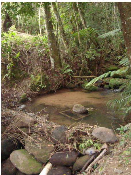
Figura F.39 - Captação no ribeirão Bibiria.
