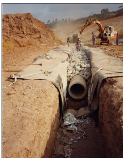
Manta de impermeabilização e tubulação de drenagem
