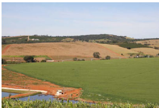
Figura 87 – Barramento no córrego da Cachoeira para abastecimento do pivô central.
