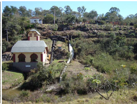
Figura 72 - Casa de força da PCH Ribeiro ou Usina Velha.
