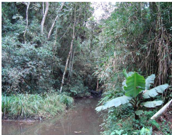
Figura 74 - Reservatório assoreado da antiga captação de Itanhandu.
