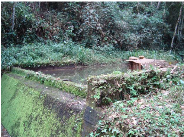
Figura 75 - Barramento da captação de Itanhandu.
