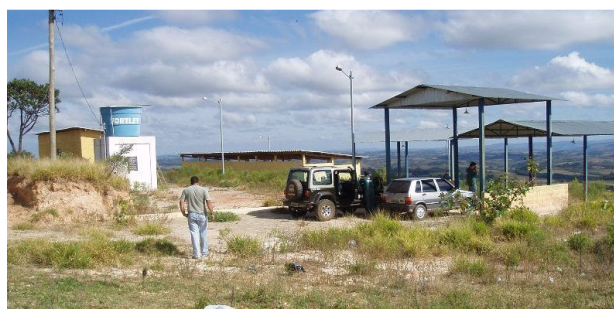
UTC de São Thomé das Letras – construída em 2008 – Está inoperante
