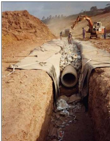
Figura 9.44 - Manta de impermeabilização e tubulação de drenagem.
