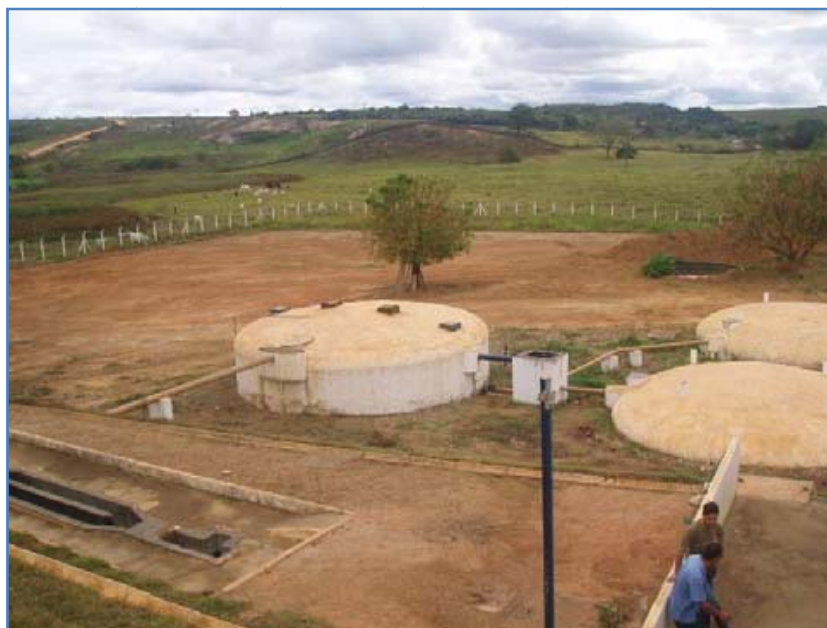
Figura 9.43 - Exemplo de Estação de Tratamento de Esgotos RAFA – Filtros. Localidade de Machado Mineiro – MG Fonte: PAOM Águas Vermelhas – PROAGUA Semiárido.
