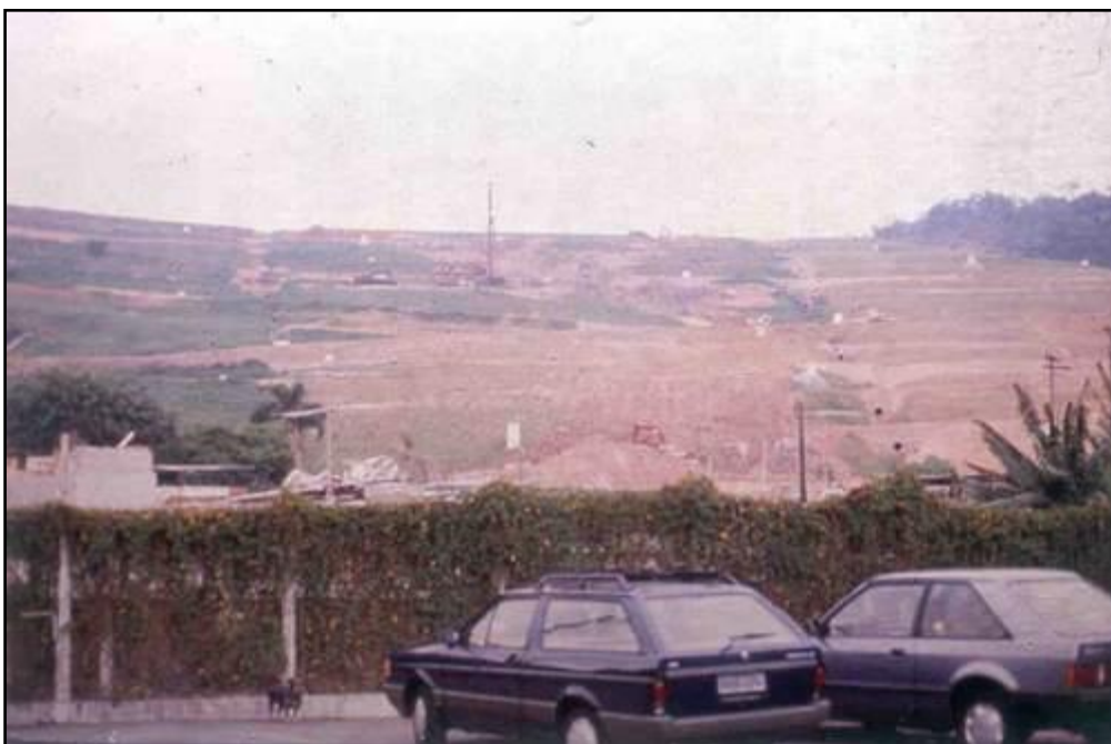
Figura A.20: Aterro em estágio quase final de conclusão das atividades
