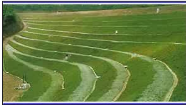
Figura A.21: Aterro totalmente concluído.
