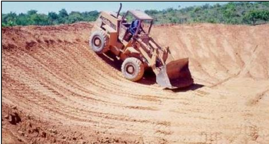
Figura A.1: Construção de bacia de contenção de enxurrada. (EMBRAPA, 1997)
