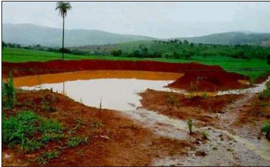
Figura A.3: Bacia de contenção recebendo as águas de enxurrada em Sete Lagoas – MG. (EMBRAPA,1997)
