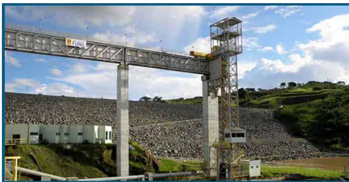
Figura 58 – Sistema de transposição de ictiofauna da Aproveitamento Hidrelétrico do Funil, cujo sistema optado foi o elevador com captura e transporte aéreo.
