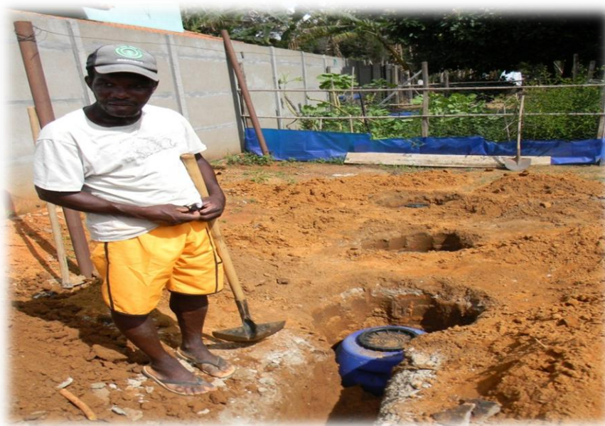
Figura 6: Instalação de fossa séptica demonstrativa na zona rural de Lagoa Santa - MG.
