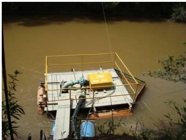
**Figura 7 – Detalhe para a balsa de captação para abastecimento doméstico da sede de São Vicente de Minas (rio Aiuruoca).**
